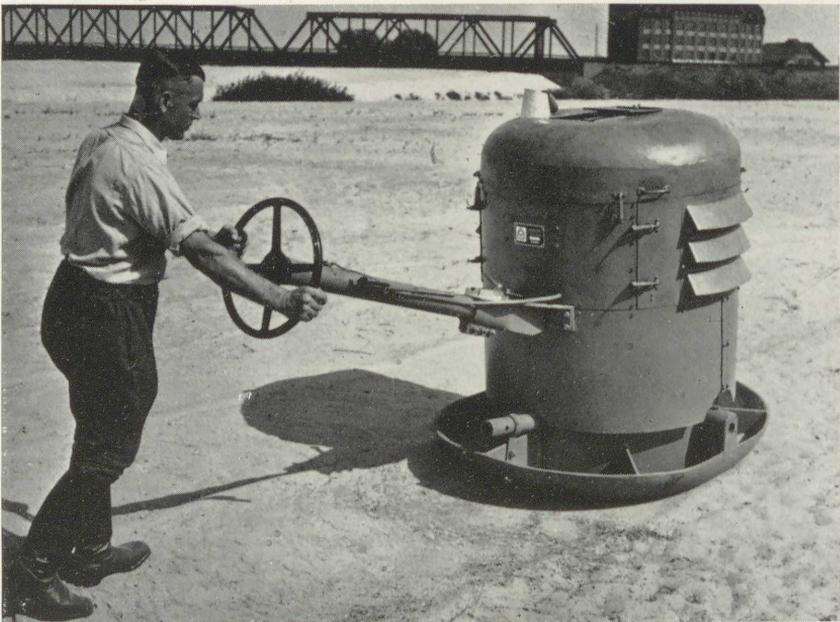
2. Neuer Schwing-Verdichter. (Werkaufnahme Losenhausenwerk, Düsseldorf)
