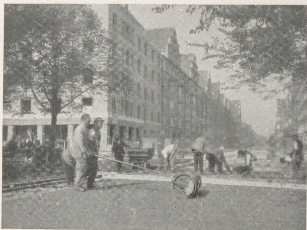
Abb. 93 Hannover, Sallstraße. Halbseitige Betonierung
