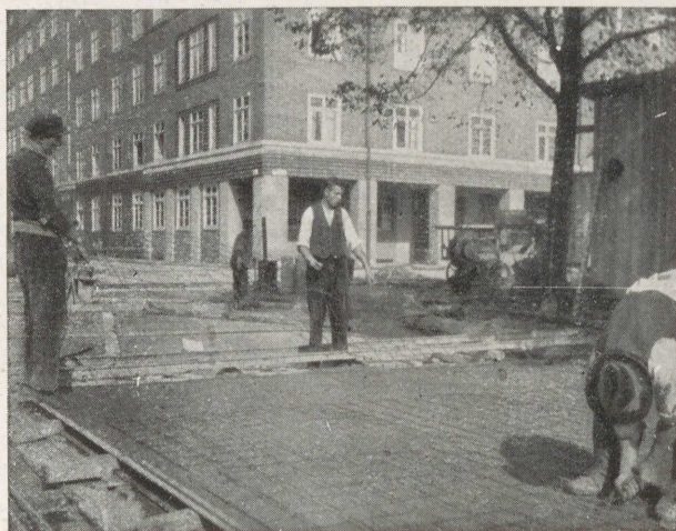
Abb. 9 Sallstraße, Hannover Verlegen und Verknüpfen des Stahldrahtgewebes
