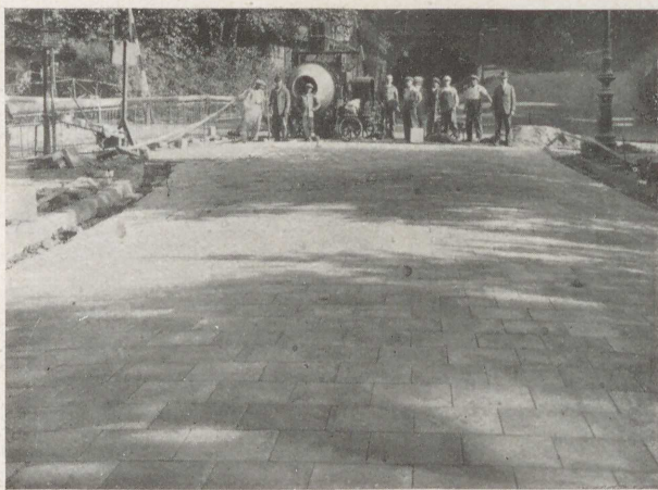
Abb. 88 Wilh.-Erb-Straße, Heidelberg Hartsteinplattenbelag (35×35×8 cm) auf 8 cm starkem Tragbeton
