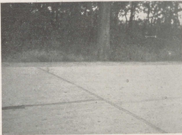
Abb. 46 Graue Vergußmasse „Befugus“ (links ein Stück mit schwarzer Vergußmasse)
