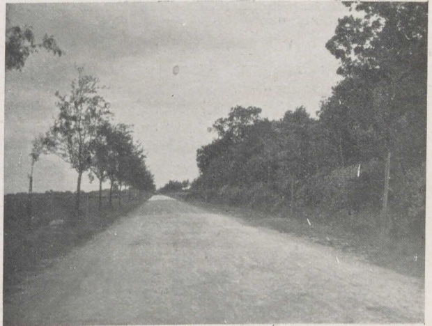
Abb. 138 Zementschotterstraße Borsum—Asel, Kr. Hildesheim Ein Jahr unter Verkehr. Vorn ohne Oberflächenbehandlung Dahinter mit Oberflächenbehandlung. Ganz im Hintergrunde Betonstraße Borsum—Asel
