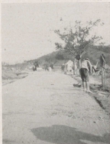
Abb. 134 Zementschotterstraße Hettensen—Lödingsen, Kr. Northeim Einlegen des oberen Mörtelausgleiches. Fertige Decke
