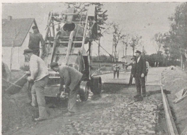
Abb. 48 Bremen—Wesermünde Herstellung der Magerbetonausgleichsschicht Ausf. Dyckerhoff & Widmann A.G. u. Wayss & Freytag A.G.
