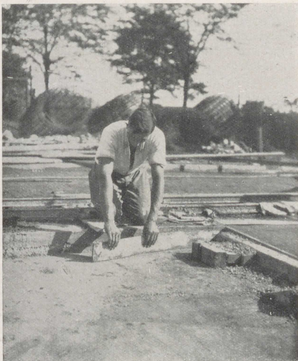
Abb. 31 Längsfugenherstellung in der Sallstraße, Hannover Steife Platte aus Palesit-Schmelzmasse
