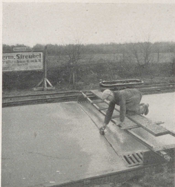
Abb. 30 Nachbehandlung der eingeschlagenen Fuge mit Handschablone. Querfugenanordnung in Höhe des Einlasses
