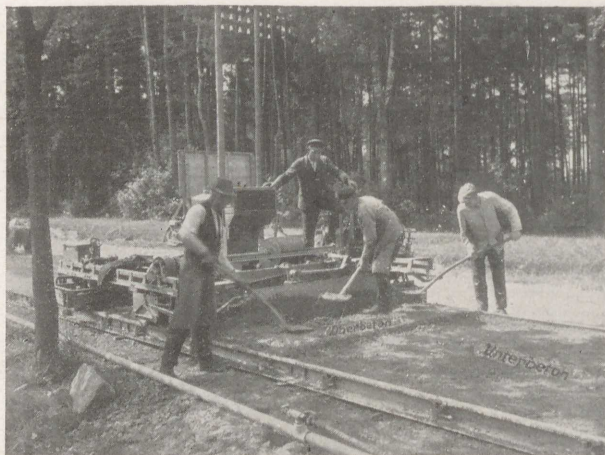
Abb. 54 Nürnberg—Feucht Straßenfertiger in Tätigkeit. Halbseitige Betonierung
