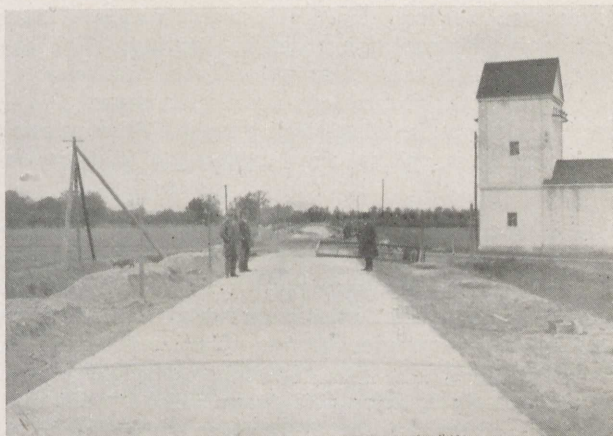
Abb. 123 Leschkowitz, Kreisgrenze Steinau/Schles. Betondecke auf Kirchner'schem Betonquaderunterbau
