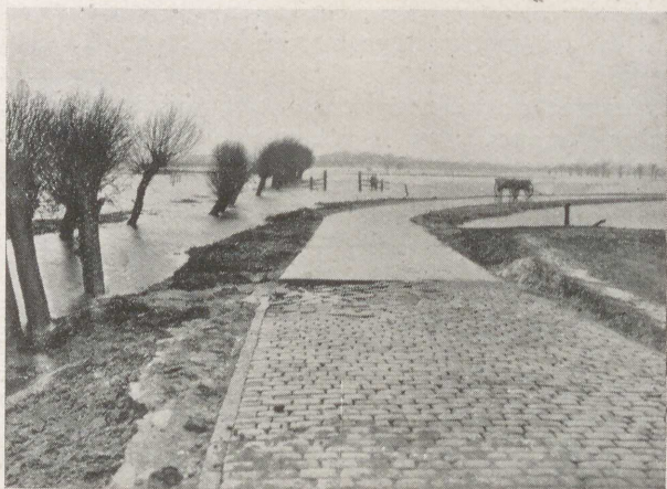
Abb. 75 Übergang vom Großpflaster zur Betonstraße Altenwerder—Finkenwärder nach dem zweiten Hochwasser im Dez. 1929
