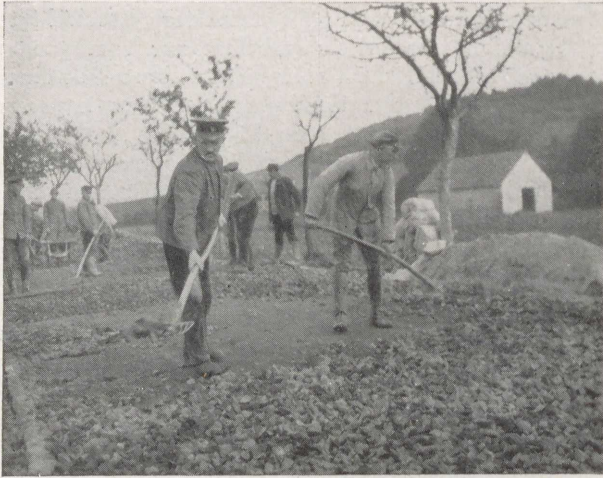
Abb. 125 Zementschotterstraße Hettensen—Lödingsen Ausbreiten der unteren Schotterlage
