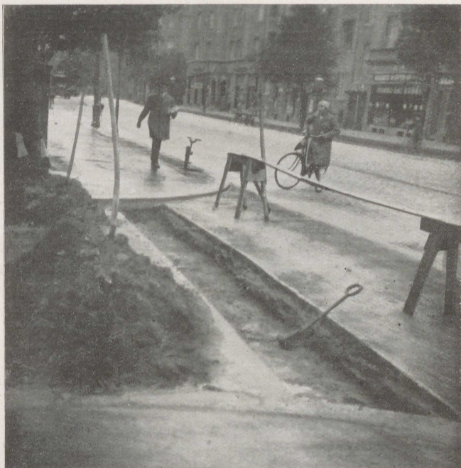
Abb. 47 Schließen eines aufgebrochenen Kabelgrabens in der Devrientstraße Hannover unter Verwendung von Tonerdschmelzzement
