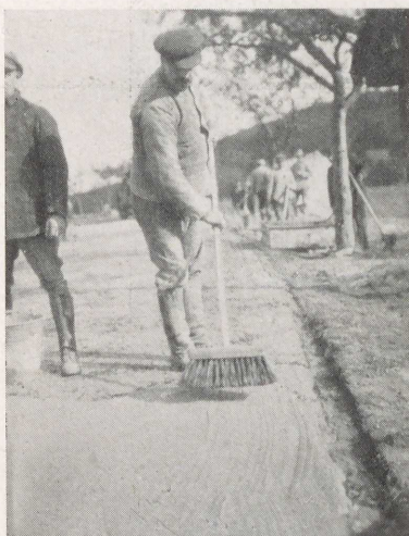
Abb. 133 Zementschotterstraße Hettensen—Lödingsen, Kr. Northeim Einbringen des oberen Mörtelausgleiches
