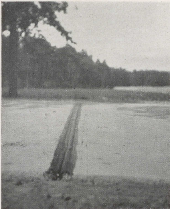
Abb. 44 Frisch ausgegossene, alte Preßfuge nach Ausstemmen des Betons. Einbügeln mittels heißem Eisen
