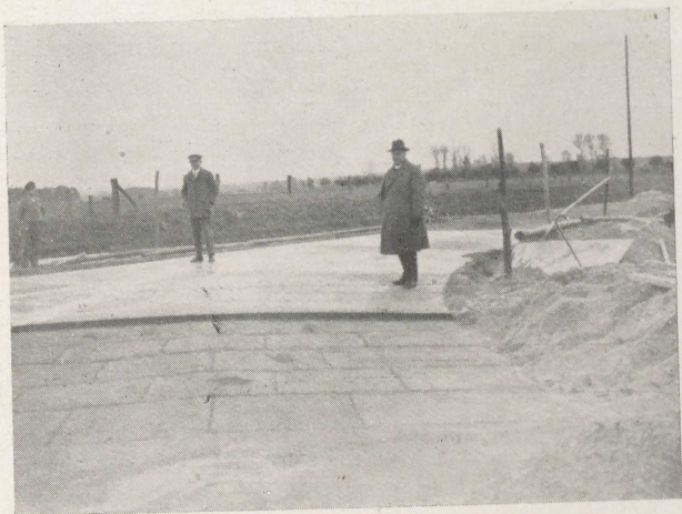
Abb. 121 Leschkowitz, Kreisgrenze Steinau/Schles. Betondecke auf Kirchner'schem Betonquaderunterbau
