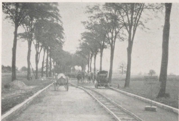
Abb. 63 Rinkerode—Ossenbeck Blick auf das Arbeitsfeld (Betonlängsschwellen)
