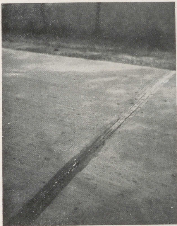
Abb. 43 Ausgestemmte, alte Preßfuge erhält Palesitverguß nach Voranstrich mit Inertol
