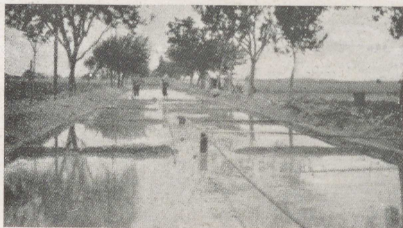
Abb. 77 Feuchthaltung des frischen Betons
