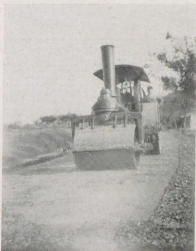
Abb. 128 Zementschotterstraße Hettensen—Lödingsen Einwalzen der oberen Schotterlage
