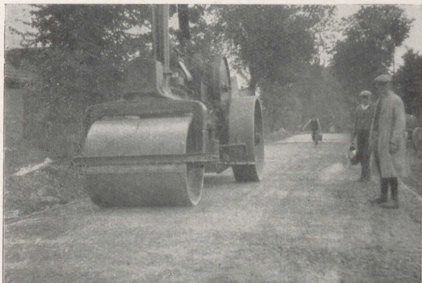
Abb. 129 Zementschotterstraße Roschkowitz/Schles. Oberfläche wird unter Begießen gewalzt. Mörtel fängt an nach oben durchzudringen
