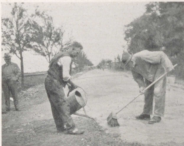
Abb. 132 Zementschotterstraße Borsum—Asel, Kr. Hildesheim Einbringen des oberen Mörtelausgleiches
