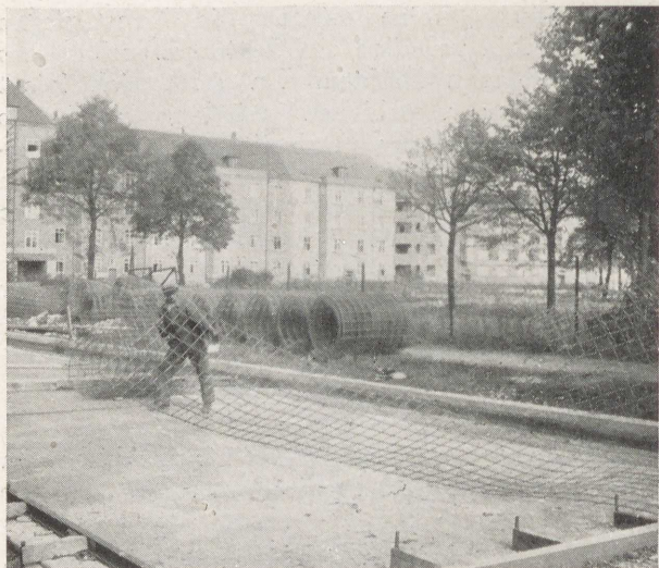
Abb. 8 Sallstraße, Hannover Auslegen der geschweißten Stahldrahtgeweberollen
