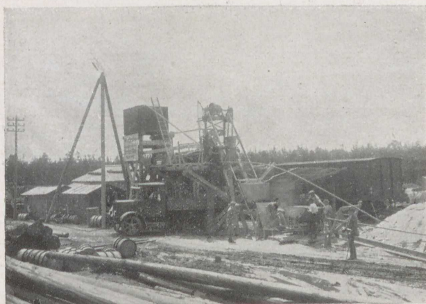
Abb. 53 Nürnberg—Feucht. Zentrale Mischanlage in Feucht
