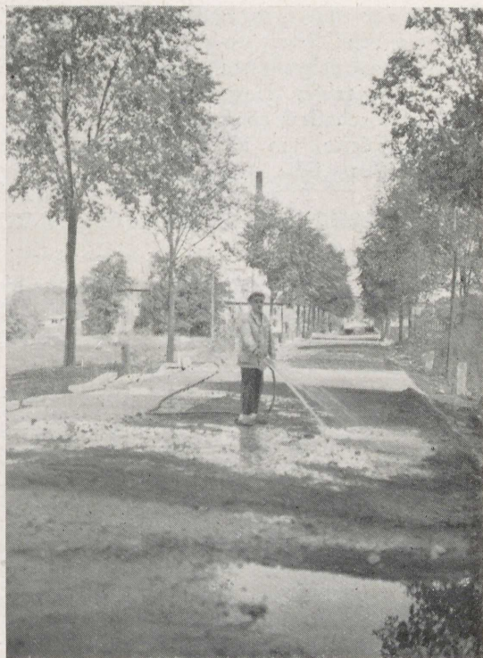
Abb. 22 Annässen der mit Sand abgedeckten fertigen Betondecke
