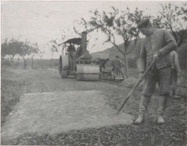
Abb. 126 Zementschotterstraße Hettensen—Lödingsen Aufbringen der Zementmörtelzwischenlage
