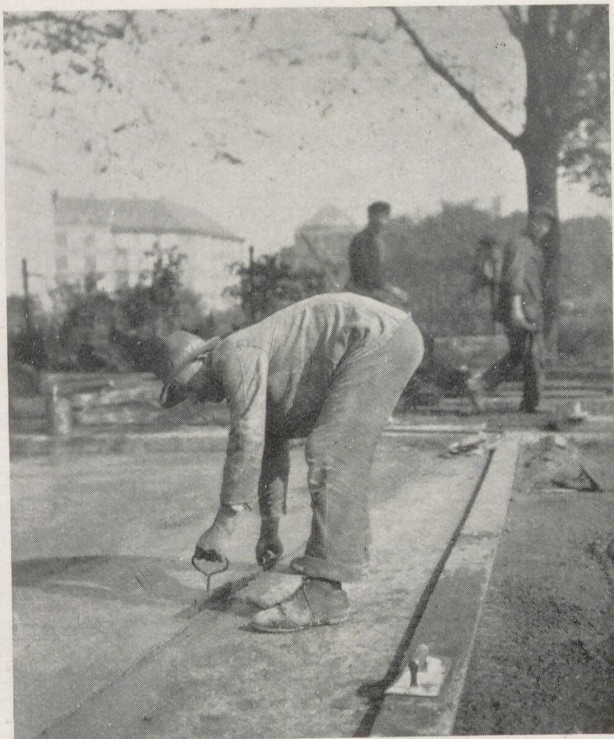
Abb. 26 Herausziehen des konischen Flacheisens sofort nach Fertigstellung des Oberbetons. Sallstraße, Hannover
