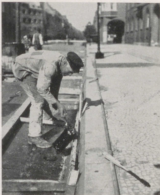
Abb. 34 Sallstraße, Hannover. Seitliche Längsfuge zwischen Hochbord und Schalung vor Betonierung der Decke gegossen
