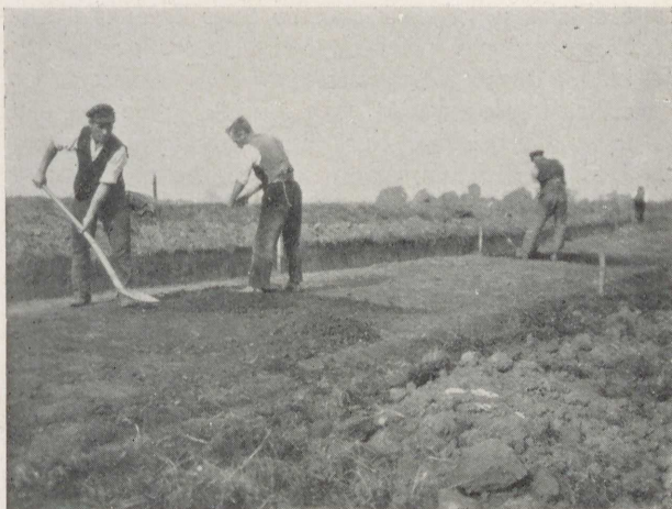
Abb. 5 Vorbereitung des Untergrundes Alter Schlackenweg Altenwerder—Finkenwärder
