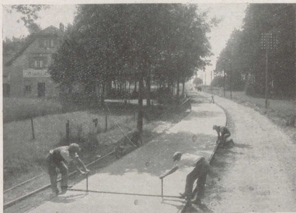
Abb. 56 Nürnberg—Feucht. Querfugenherstellung
