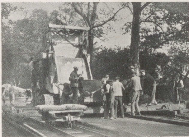
Abb. 49 Bremen—Wesermünde. Beschickung der Mischmaschine
