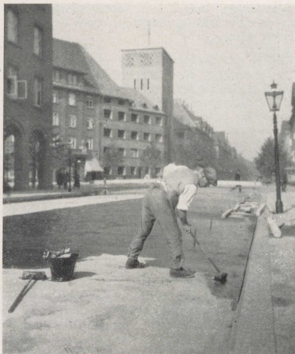
Abb. 6 Vorbereitung des Untergrundes, Bitumenanstrich des alten, vorhandenen Unterbetons in der Sallstraße, Hannover
