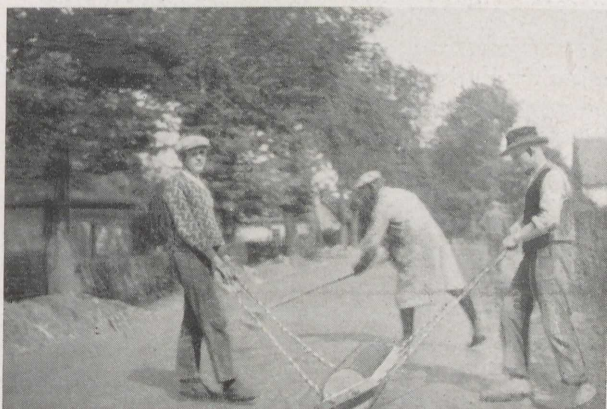
Abb. 135 Zementschotterstraße Roschkowitz/Schles. Querwalzen mit schwerer Handwalze zur Beseitigung der bei der Dampfwalzung entstandenen Rillen und Abkehren der überflüssigen Zementschlämme
