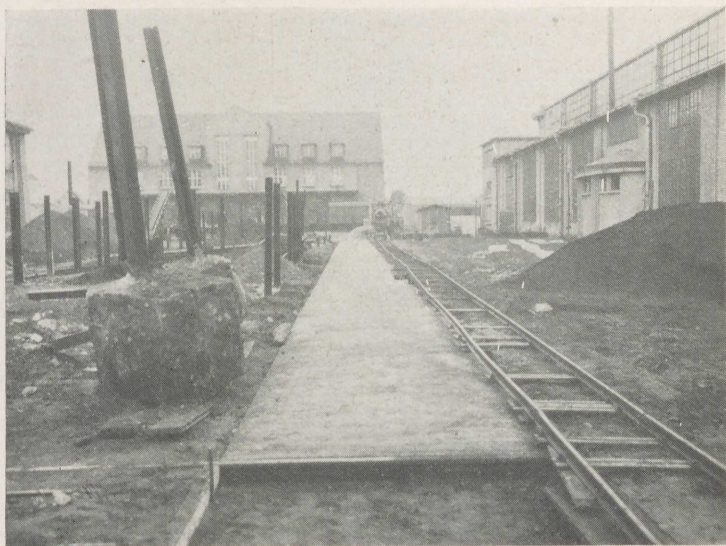
Abb. 105 Oels i. Schlesien, Elektrokarrenbahn im Reichsbahnausbesserungswerk Oels. Ausf.: Rob. Kieserling, Altona/E.
