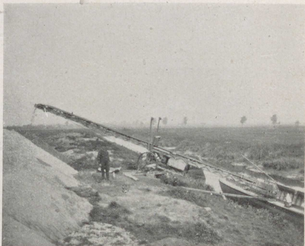
Abb. 70 Altenwerder—Finkenwärder Materialbeförderung aus 30-t-Schuten
