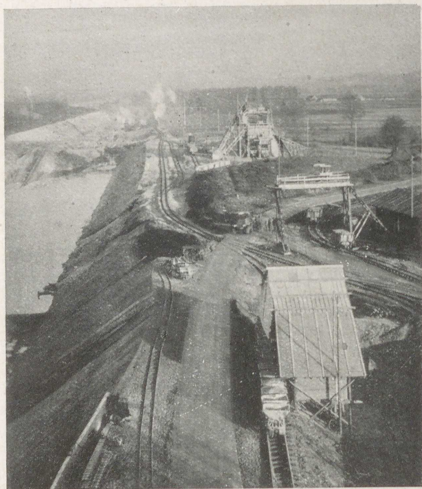
Abb. 107 Städt. Kraftwerk Uppenborn/München Betonzufahrtsstraße zur Baustelle Unterwasserkanal und Kiesaufbereitungsanlage
