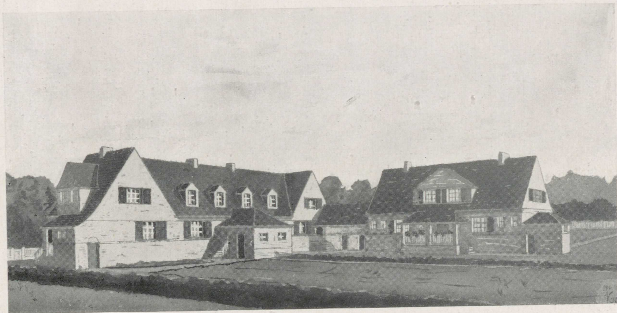
Abb. 10. Ansicht der Häusergruppe von der Straßenseite.
