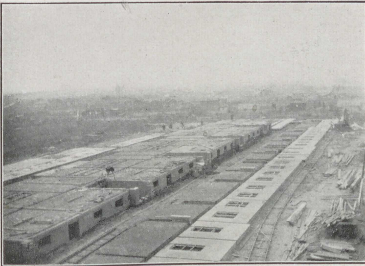
Abb. 29. Fertiggestellte Wandtafeln.
