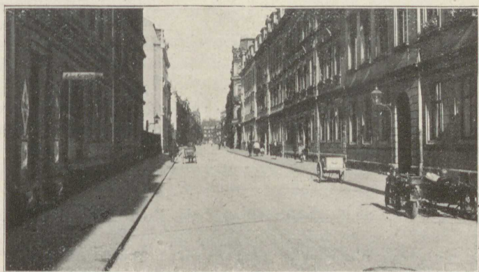
12*) Dresden, Förstereistr., 1909 gebaut, 6,8-8,4 m breit; Querfugen unt. einem Winkel v. 20-30° z. Straßenachse
