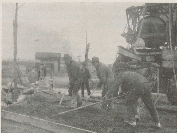
56 Rudower Chaussee, Berlin: Ausbreiten des Betons
