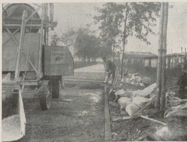
57 Rudower Chaussee, Berlin: Abziehen des Betons
