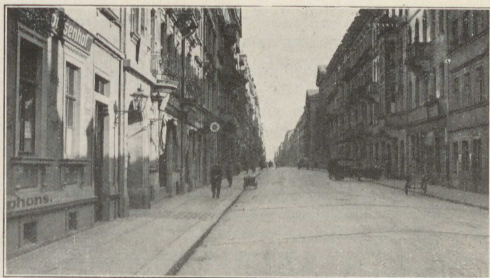
11*) Dresden, Louisenstraße. Baujahr 1907/09, 8,85 m breit; Querfugen im Abstände von 12 m senkrecht zur Straßenachse, mit Flacheiseneinlagen. Fast völlig unbeschädigt und rissefrei.
