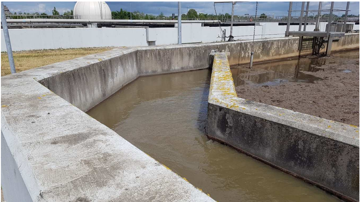
Rys. 10 Miejsce poboru ścieków do badań (Oczyszczalnia Ścieków „Pomorzany”)
