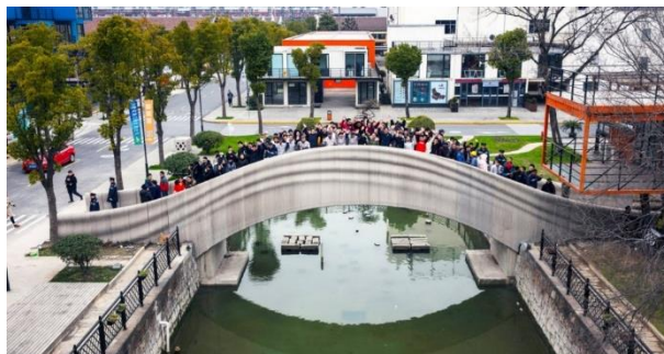
Rysunek 7. Kładka dla pieszych wydrukowana w technologii druku 3D, Szanghaj, 2019 [34].
