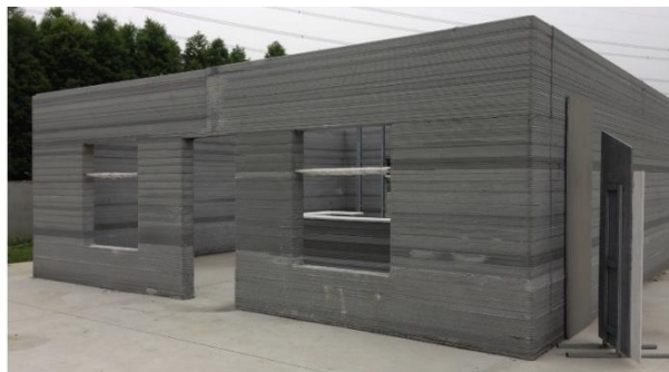
Rysunek 8. Budynek mieszkalny o konstrukcji wykonanej w technologii contour crafting przez firmę WinSun [27].
