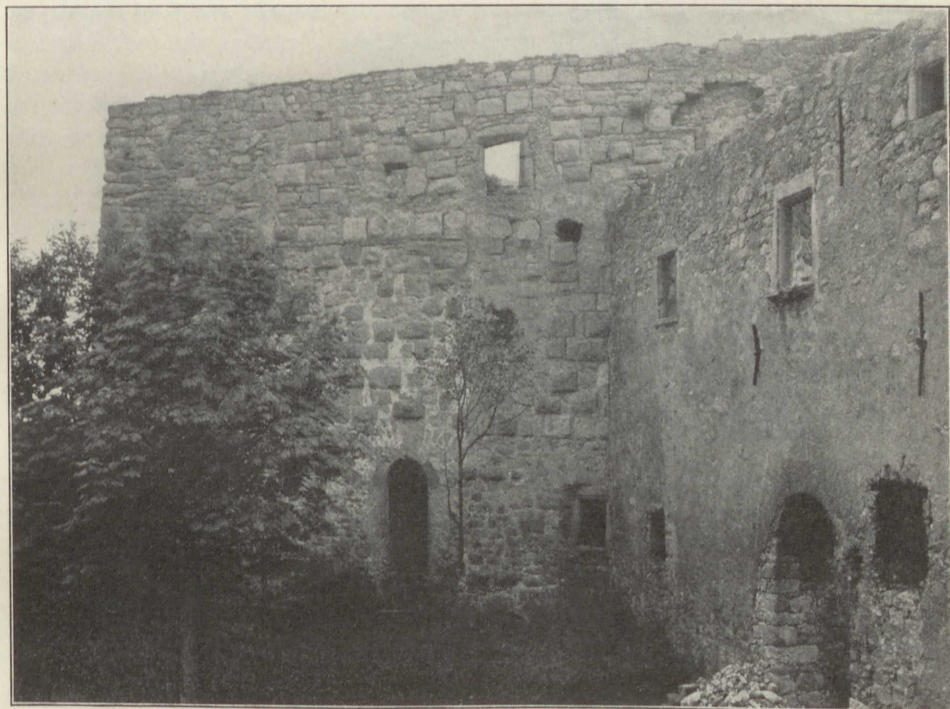
Fig. 45. Leuchtenberg. Nordwand des Palas, 1906.
