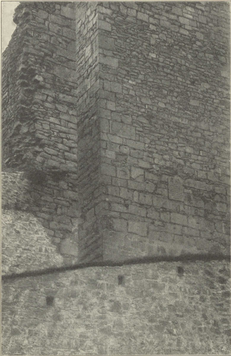
Fig. 26. Obermurach. Mauerwerk am Bergfried (rechts) und Getreidekasten (links).
