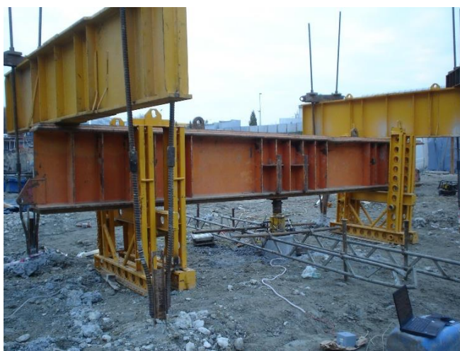
Rys. 5. Zdjęcia stanowiska badawczego do próbnego obciążenia pala (Żarkiewicz, 2012)
