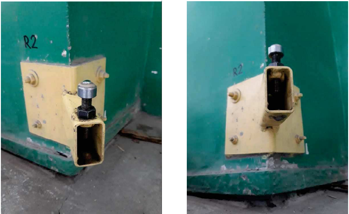
Ryc. 4.3. Fotografia przedstawiająca jeden z badanych reperów regulowanych (fotografia własna)
