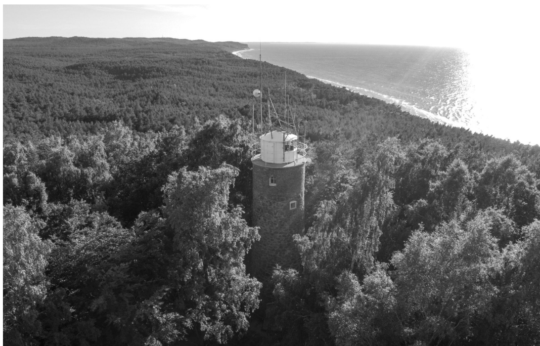
Fot. 20. Latarnia morska Kikut z loku ptaka.
