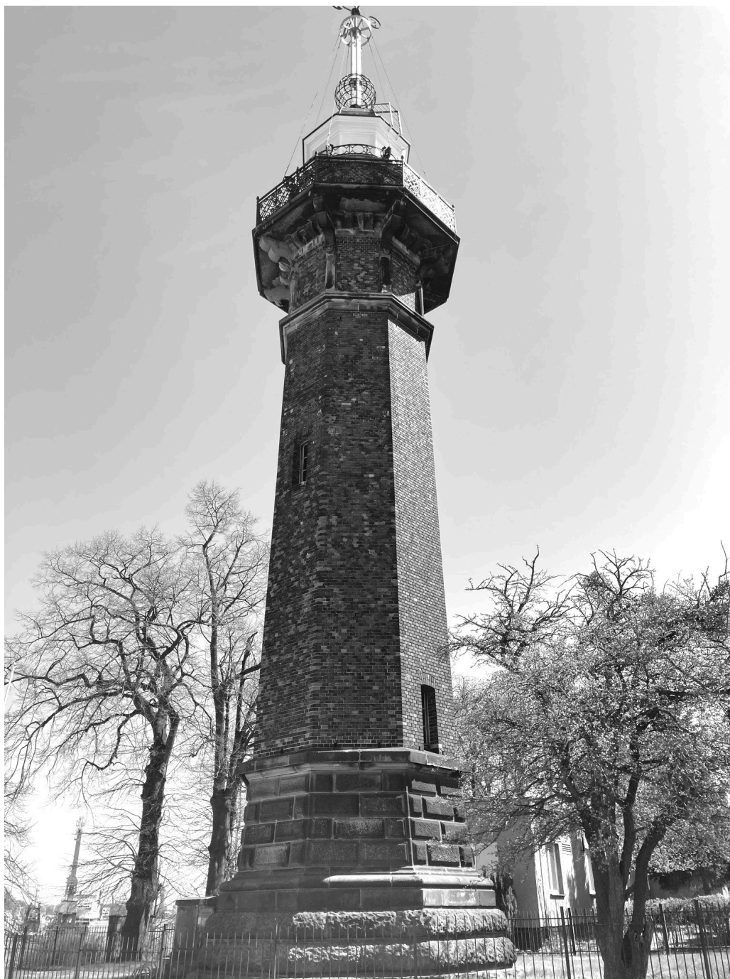
Fot. 72. Widok latarni morskiej Gdańsk Nowy Port, maj 2021r.
