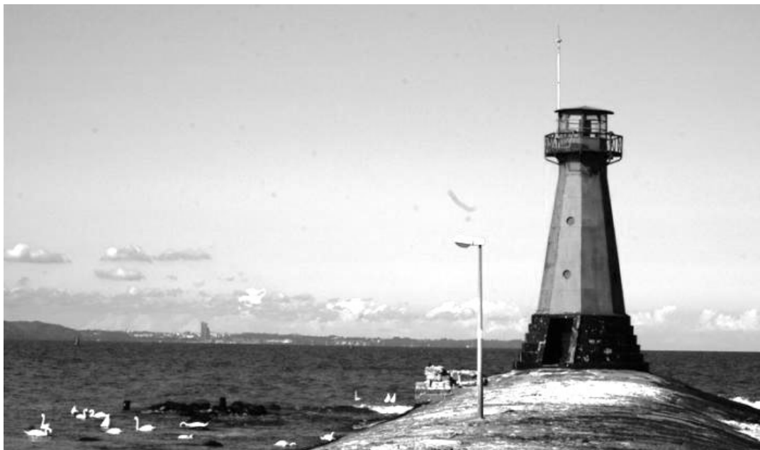
Fot. 85. Widok latarni morskiej Gdańsk Westerplatte przed demontażem w 2012r.
