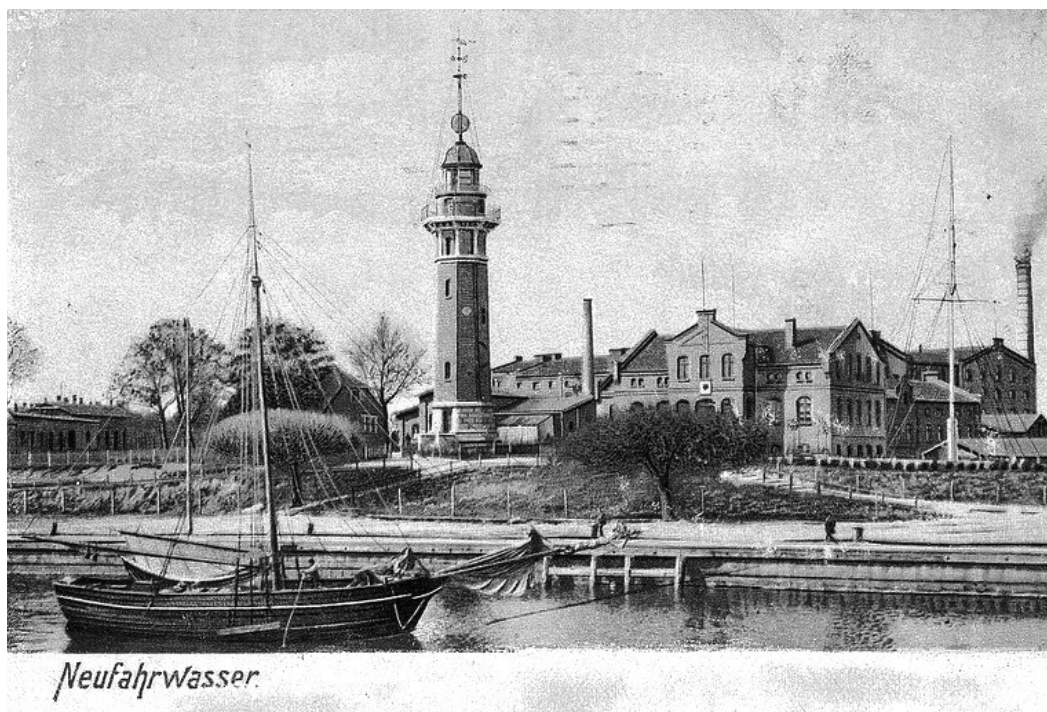
Ryc. 56. Archiwalna dokumentacja latarni morskiej Gdańsk Nowy Port.
