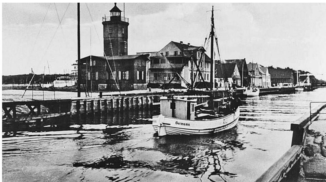
Ryc. 33. Archiwalny widok latarni morskiej Darłowo.
