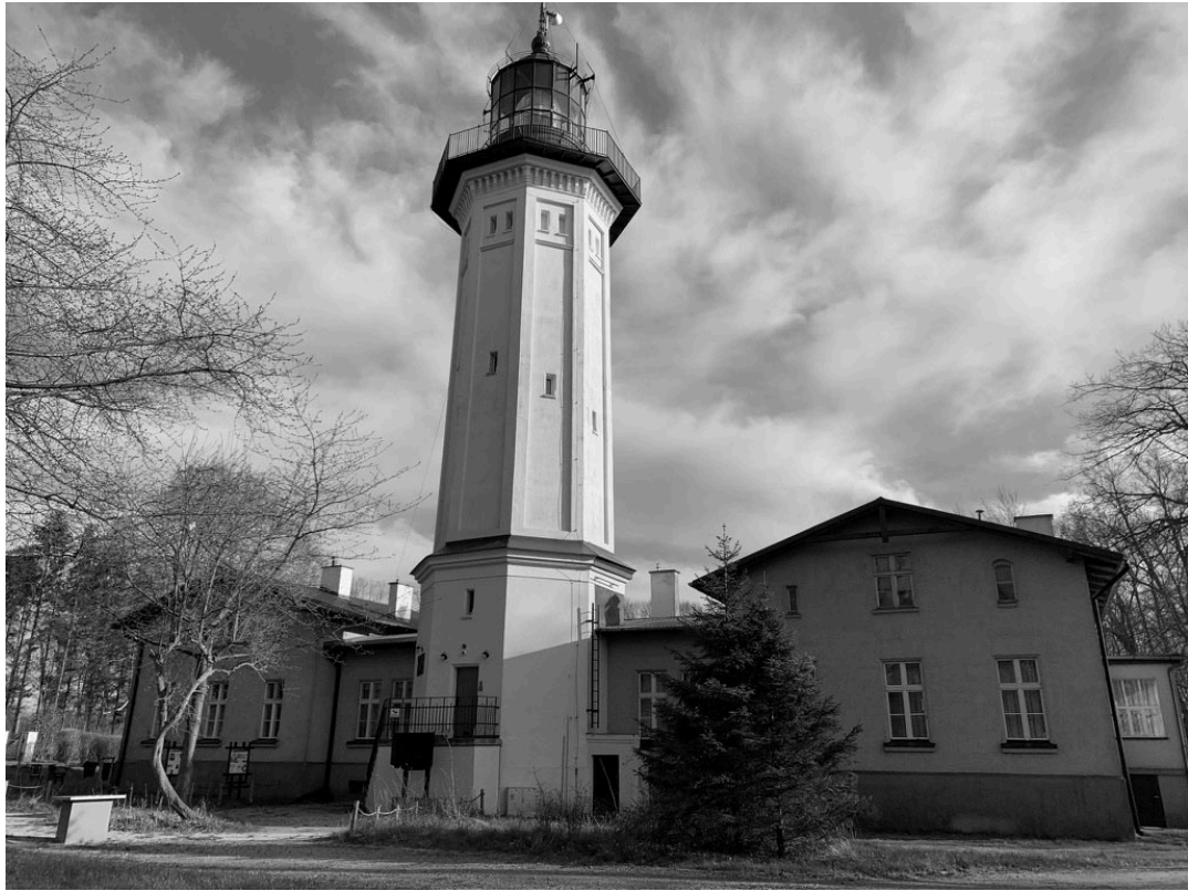
Fot. 51. Kompleks latarni Rozewie II od strony północnej, kwiecień 2021r.
