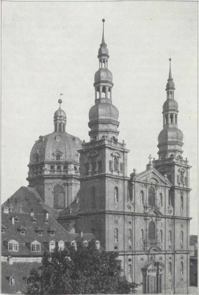
Abb. 90. Fassade und Kuppel von Stift Haug.
