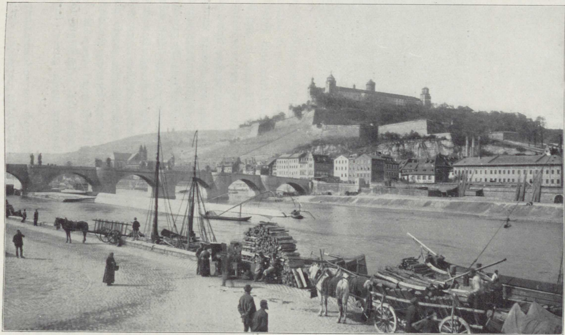
Abb. 134. Die alte Mainbrücke Blick auf die Festung.
