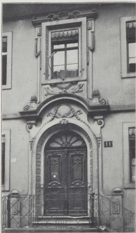
Abb. 138. Fassade des Hauses Nr. 11 in der Bahnhofstraße (Curia domini Murrelini).
