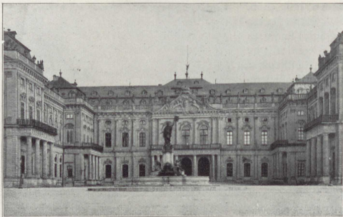
Abb. 100. _Mittelpartie der Residenz gegen den Haupthof.
