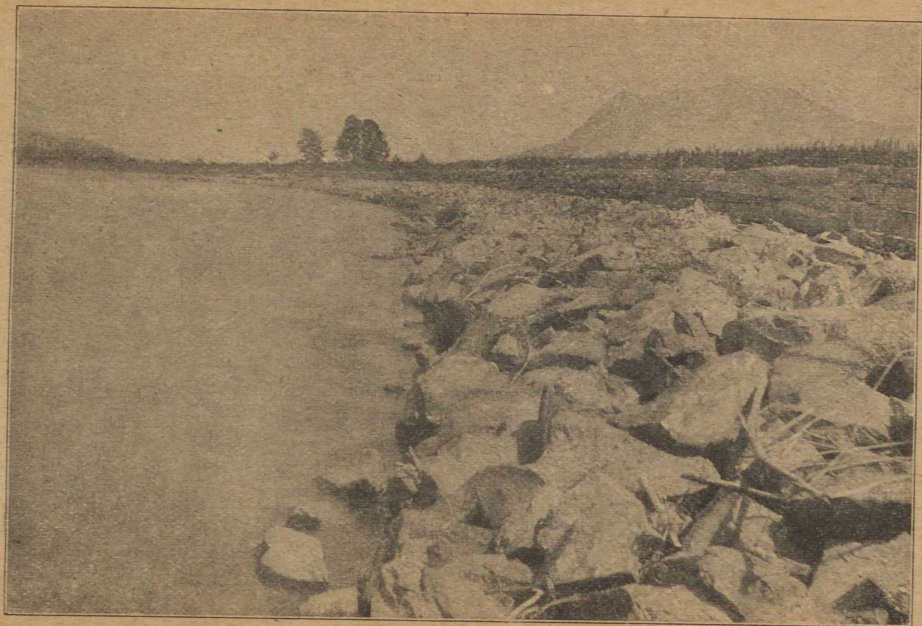
Abb. 17. Steinberollung aus Natursteinen als Uferschutz.
