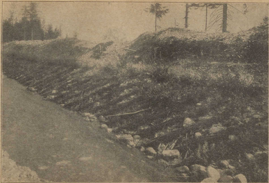
Abb. 22. Berauhwehrung als Uferschutz
