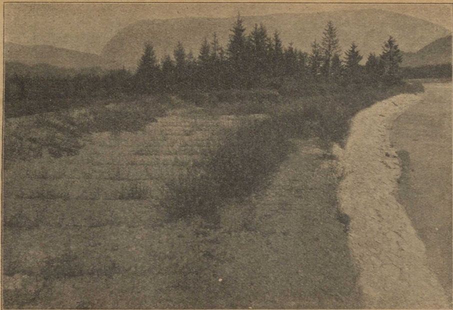
Abb. 19. Weidenpflanzungen als Uferbefestigung.
