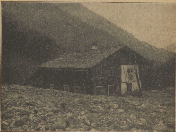
Abb. 81. Verschüttung eines Hauses bis zu halber Höhe mit Geröllmassen
