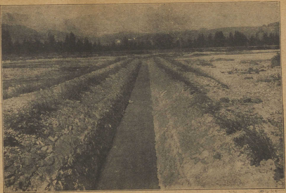
Abb. 103. Schale mit Sohle aus Bohlenbelag.
