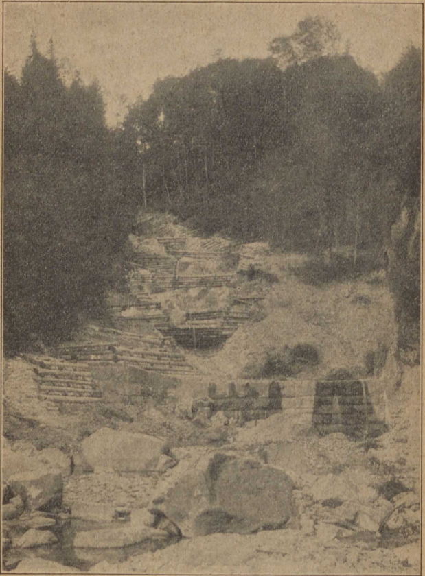
Abb. 97. Steinkastenbauten in der Dornbirner Ache.
