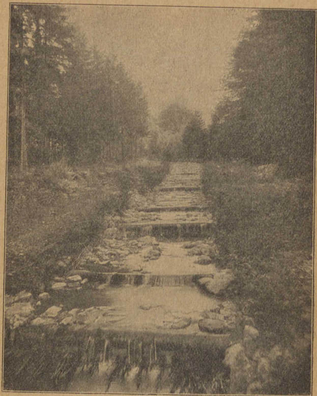
Abb. 102. Schale mit Abstürzen aus Holzschwellen und Faschinensturzbett.
