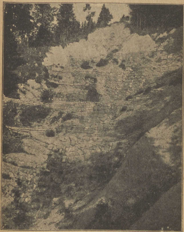
Abb. 79. Oberstes Einzugs- und Abbruchgebiet des Kapellenbaches bei Immenstadt mit seinen Verbauungen.
