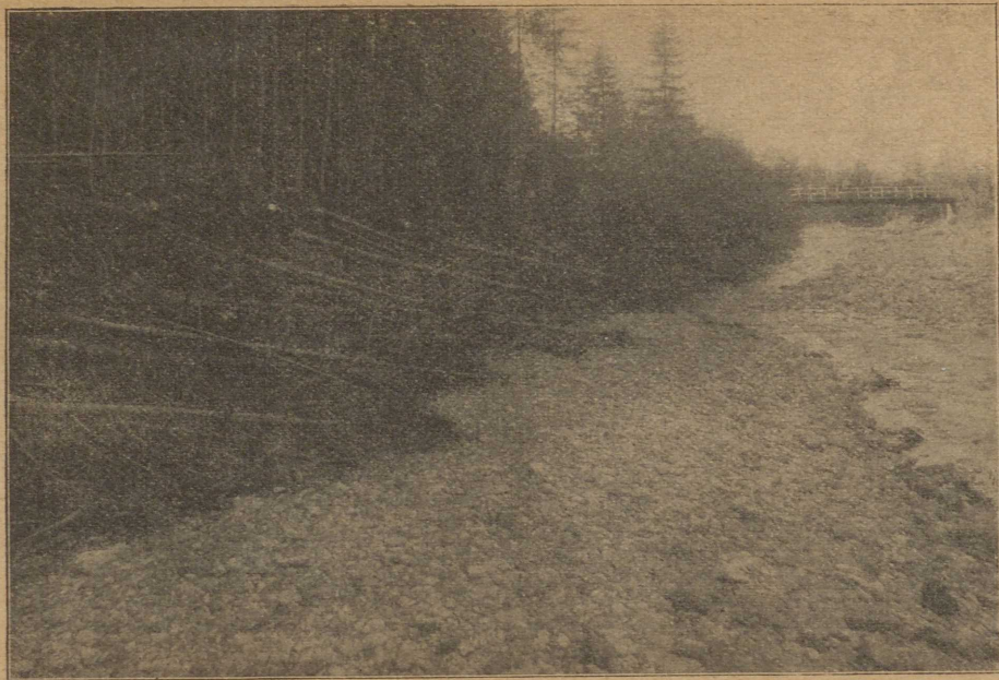
Abb. 23. Provisorischer Uferschutz mit Raubbäumen.
