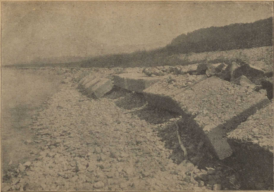
Abb. 18. Betonsenkstücke als Uferschutz
