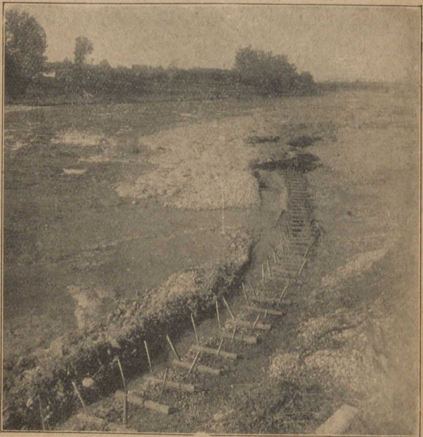
Abb. 10. Anfertigung von Senkwellen. Faschinenbank.
