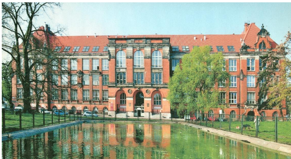
Fot. 1. Budynek Wydziału przy ul. Pułaskiego 10.
