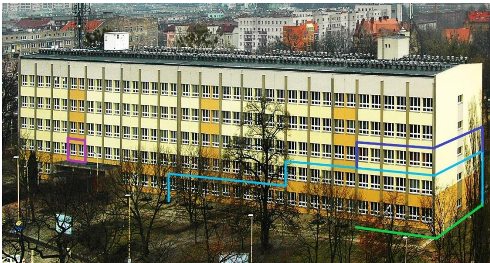
Fot. 5. Pomieszczenia Zakładów Inżynierii Chemicznej po roku 2002.
