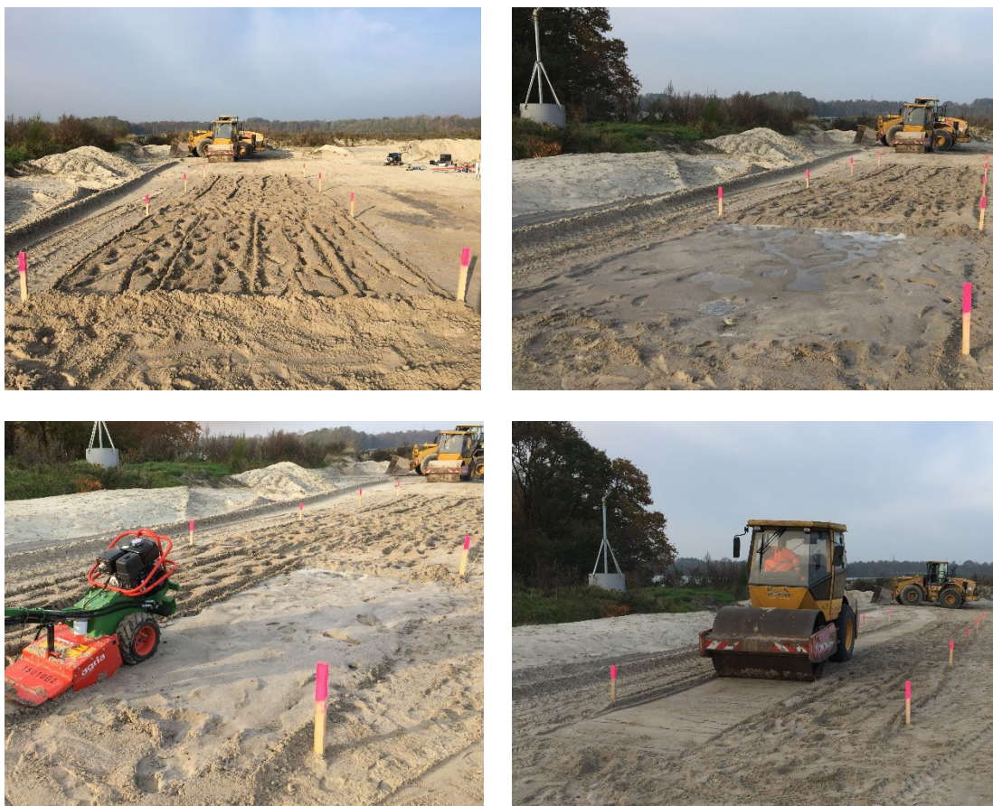
Rys. 5.5 Przygotowanie pól testowych: spulchnione pola testowe (u góry po lewej), nawilżone pola testowe (u góry po prawej), ponowne spulchnianie nawilżonych pól testowych (na dole po lewej), zagęszczanie pól testowych (na dole po prawej)
