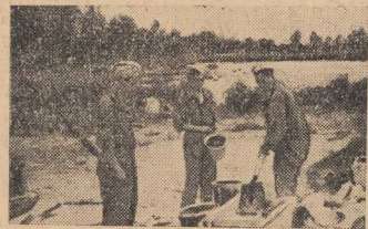
Zanim rozpocznie się budowę fundamentów, należy przygotować zaprawę murarską. Doskonale to robią trzej kandydaci do szkoły Jungów: Pułacz-Huraszkiewicz Plusko i Nowicki
