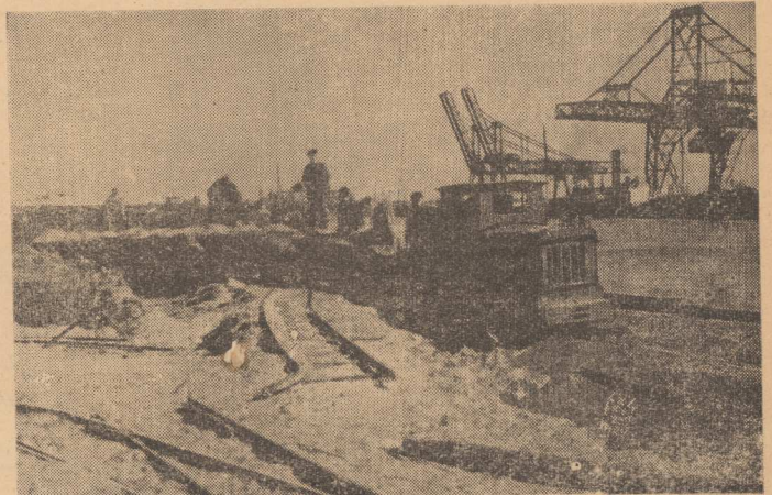
Budowa basenu węglowego w porcie szczecińskim
