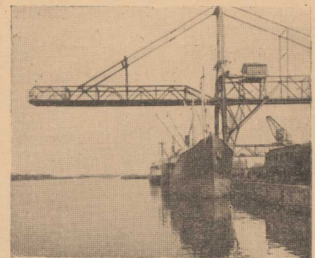
Dźwig mostowy na Nabrzeżu Kaszubskim
