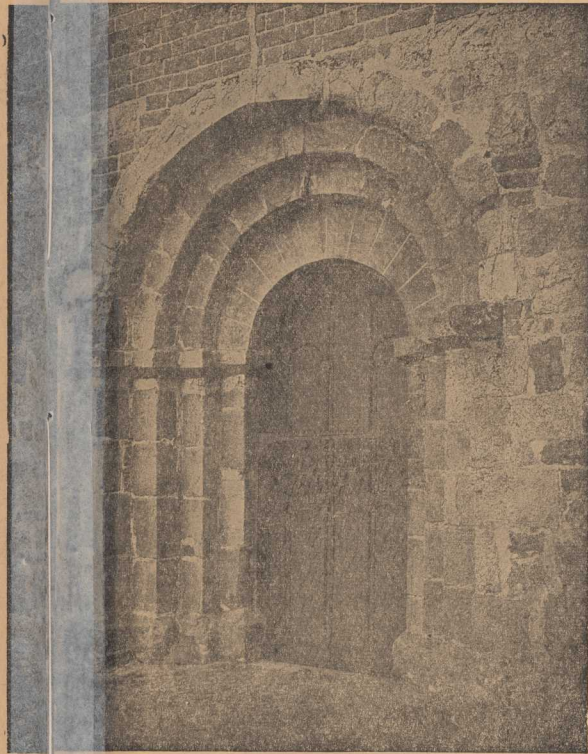
Portal starej katedry w Kamieniu
