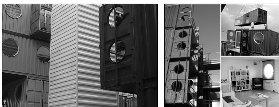
Ryc. 7.48. Container City w Londynie według projektu biura Nicholas Lacey and Partners jako przykład recyklingu kontenerów transportowych na potrzeby przestrzeni mieszkalnych Źródło: Container City, http://www.containercity.com , dostęp 24.09.2008.
