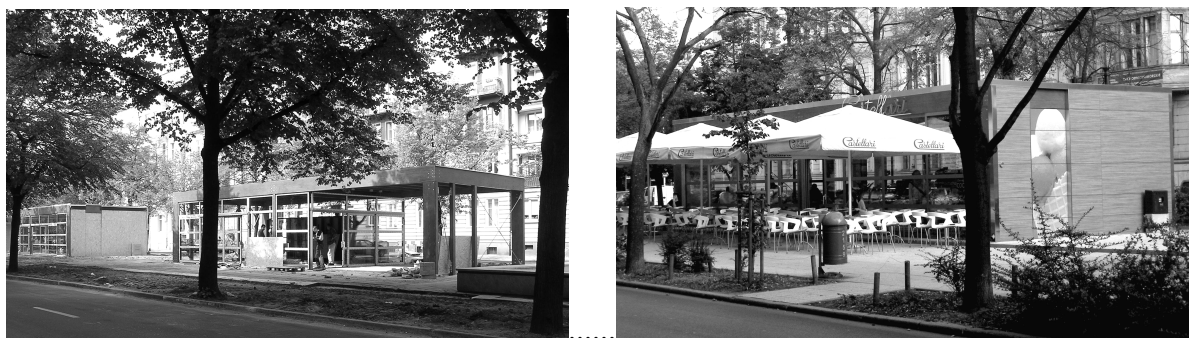
Ryc. 7.11. Pawilony gastronomiczne w przebudowanym ciągu alei fontann w Szczecinie jako przykład rematerializacji – zamiany energochłonnej konstrukcji żelbetowej na lekkie ramy z drewna klejonego Fot. autora.
