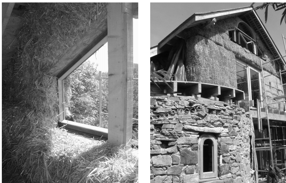
Ryc. 7.44. Realizacja budynku jednorodzinnego zaplanowanego przez grupę Amazonees w południowej Walii z użyciem materiałów lokalnych, w tym beli z prasowanej słomy oraz kamieni polnych, jako przykład rematerializacji
