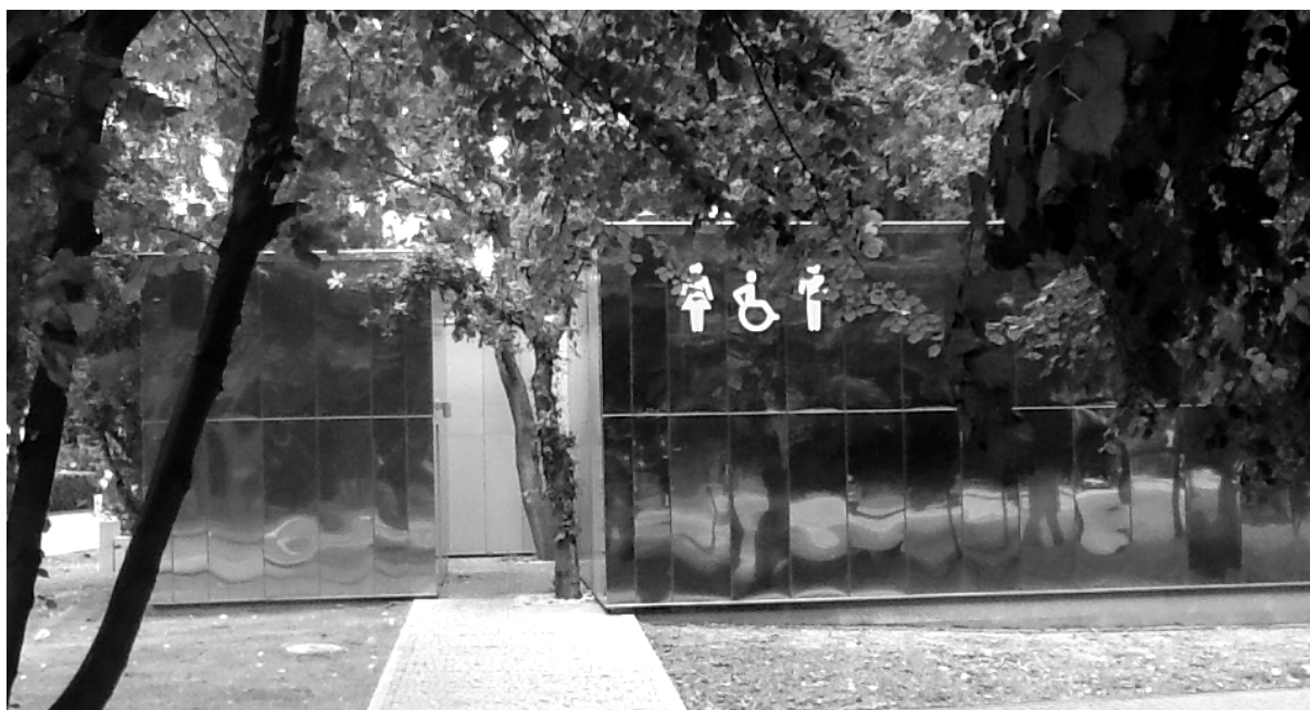
Ryc. 10.1. Toaleta publiczna w Pobierowie według projektu autora i Pracowni Projektowej AKCENT jako próba wpisania się w formułę architektury zrównoważonej. Zastosowano rozwiązania energooszczędne, urządzenia redukujące zużycie wody, materiały dobrano na podstawie metody preferencji środowiskowej. Minimalistyczna forma budynków, estetyka prostoty, dobór refleksyjnej fasady, wtapiającej obiekt w tło zieleni parkowej, kształtują klimat pozornej dematerializacji architektury Fot. autora.
