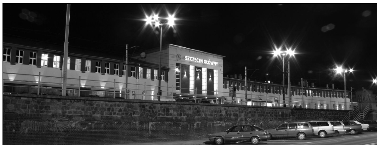
Ryc. 7.8. Elewacja budynku dworca PKP Szczecin Główny po przeprowadzeniu termorenowacji i zabiegów kompozycyjnych scalających sylwetę obiektu złożonego z czterech połączonych budynków
