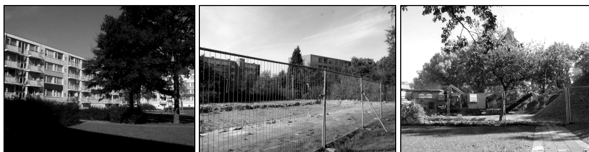
Ryc. 7.27. Budynki z wielkiej płyty, zrealizowane pod koniec lat 60. w dzielnicy Hoogvliet (Rotterdam), obecnie obszar pozyskiwania materiałów budowlanych. Rozbierane elementy konstrukcyjne, przetwarzane na miejscu przez urządzenia rozdrabniające gruz budowlany, stają się surowcami do budowy nowych domów mieszkalnych w bezpośrednim sąsiedztwie
