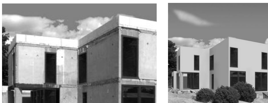
Ryc. 7.33. Przykładowe wille miejskie wykonywane z odzyskanych prefabrykatów z wielkiej płyty na terenie dawnego Berlina Wschodniego
