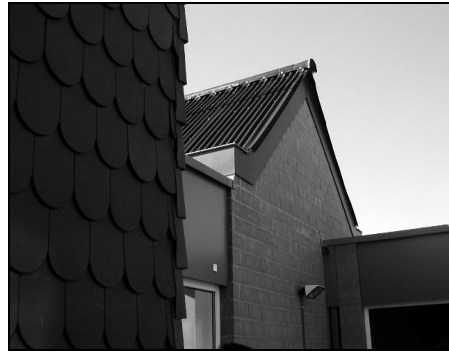
Ryc. 7.49. Recyhouse – projekt demonstracyjny budynku wykonanego w 100% z materiałów pochodzących z recyklingu, zrealizowany przez Belgijskie Centrum Technologii Budowlanych (WTCB) pod Brukselą
