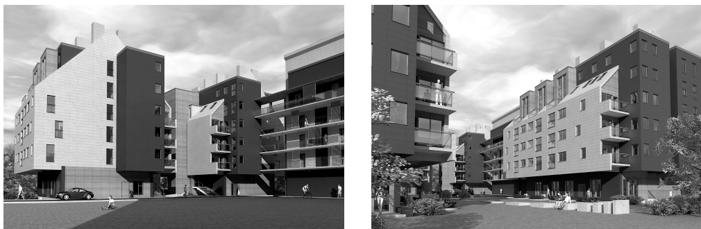
Ryc. 7.13. Intensywna wielorodzinna zabudowa mieszkaniowa przy ul. ks. Jerzego Popiełuszki jako przykład uzyskania relatywnie dużej powierzchni użytkowej przy administracyjnie narzuconym niskim wskaźniku zabudowy
