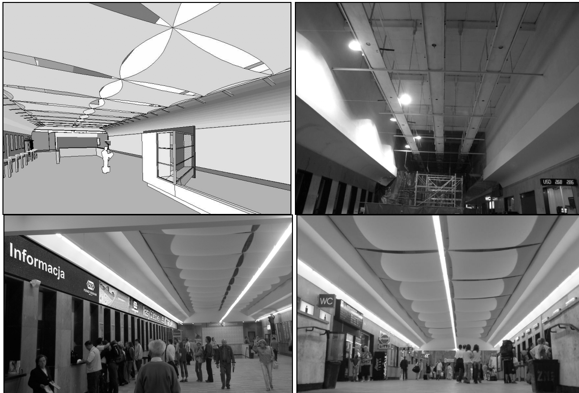
Ryc. 7.10. Projekt i realizacja aranżacji holu kasowego remontowanego budynku dworca PKP Szczecin Główny – zastosowanie podwieszanych połączy płótna żeglarskiego na ściągach stalowych pozwoliło na efektywne przekrycie pustej przestrzeni nad holem
