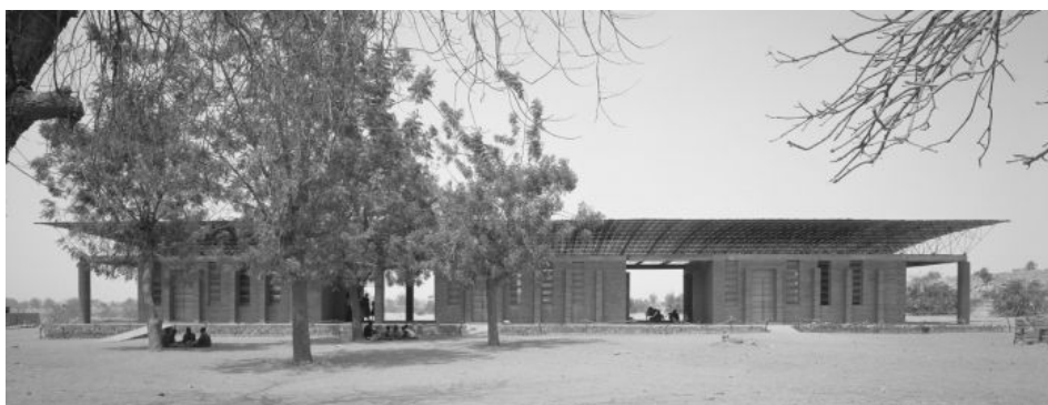
Ryc. 5.7. Szkoła podstawowa w Gando w Burkina Faso według projektu Diébédo Francis Kéré (wówczas studenta architektury), zrealizowana w konstrukcji prasowanych cegieł ziemnych. Powrót do tradycyjnych, lokalnych materiałów budowlanych we współczesnej Afryce napotyka mentalny opór, ponieważ użycie cegieł ziemnych, gliny czy mułu kojarzone jest z ubóstwem i brakiem postępu
