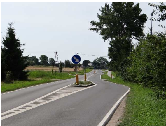
Ryc. 6.19. Odcinek Trzebusz 1 i brak widoku sylwety wsi i widocznych zabudowań po stronie pasa wjazdowego ( \Delta v_{85} = 5,4 km/h)
