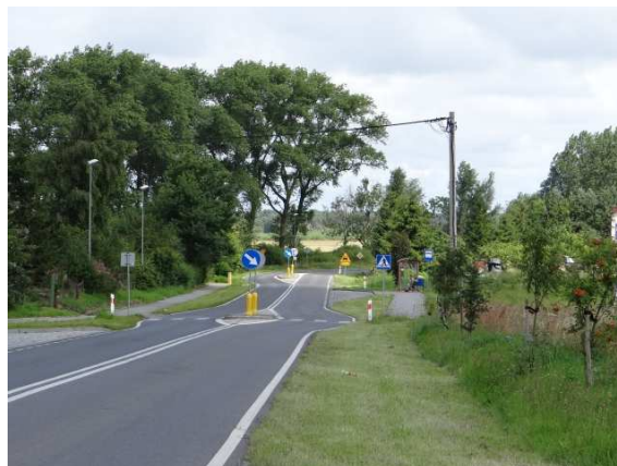
Ryc. 9.13. Widok odcinka badawczego Trzebusz 1 (wyjazd) oraz szykany na odcinku Trzebusz 1
