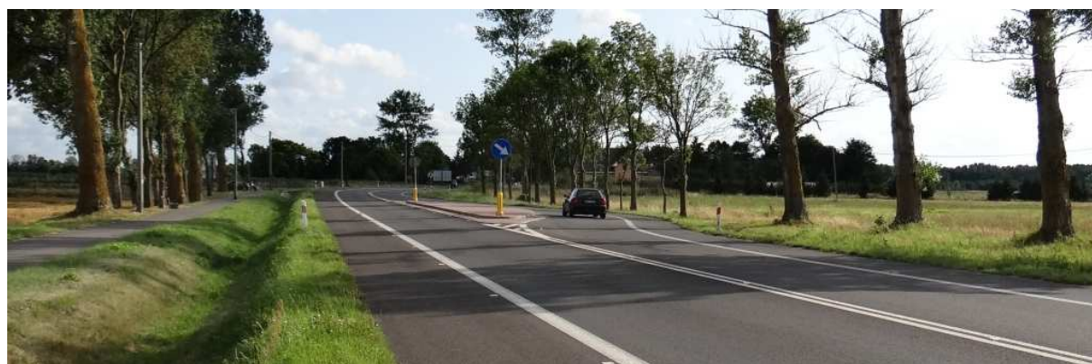
Ryc. 6.21. Odcinek Wrzosowo Osiedle 1: brak widoku sylwety wsi oraz znak B-34 (koniec 50 km/h) ustawiony zaraz za szykaną na drodze z poboczami utwardzonymi ( \Delta v_{85} = 0,2 km/h)
