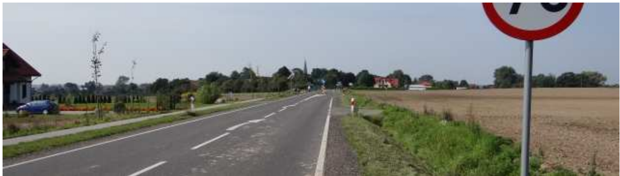
Ryc. 8.11. Strefa wjazdowa – Iwęcino 2 w terenie rolniczym otwartym – \Delta v_{sr}^{ppj} = 8,9 km/h, widoczne zabudowania w odległości 200 m od szykany
