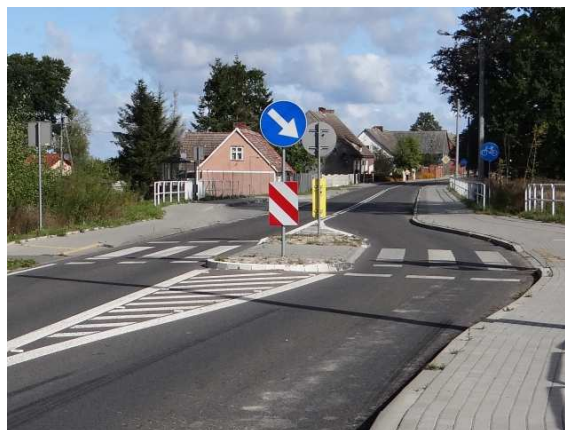
Ryc. 3.40. Wysoki krawężnik na krawędzi drogi na wyjeździe z szykany i widok bliskiej zabudowy we wsi Gleźnowo 2
