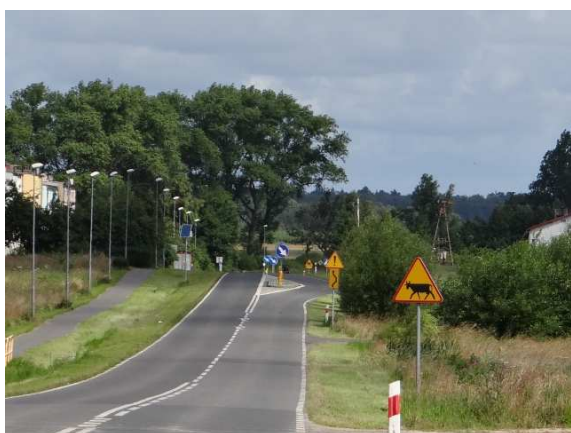
Ryc. 9.14. Widok odcinka badawczego Trzebusz 3 (wyjazd) poprzedzającego azyl dla pieszych i zjazd
