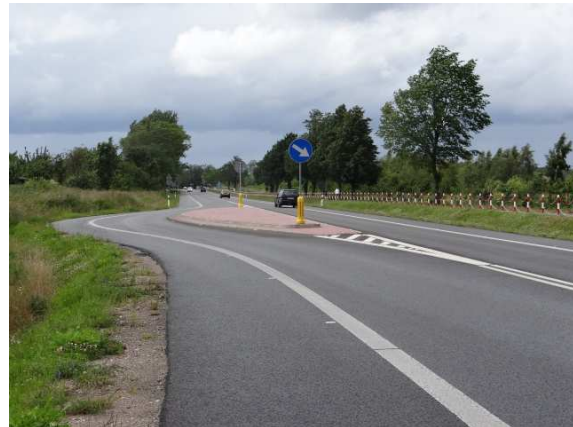
Ryc. 3.7. Szykana jednostronna półokrągła z odgięciem toru jazdy od kierunku prostego o 6 m
