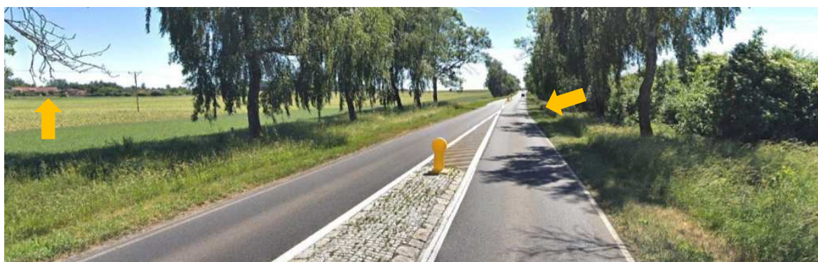
Ryc. 9.4. Widok sylwetki wsi Lipnik na odcinku Brodniki 1 i złudzenie optyczne zwężenia jezdni [118]
