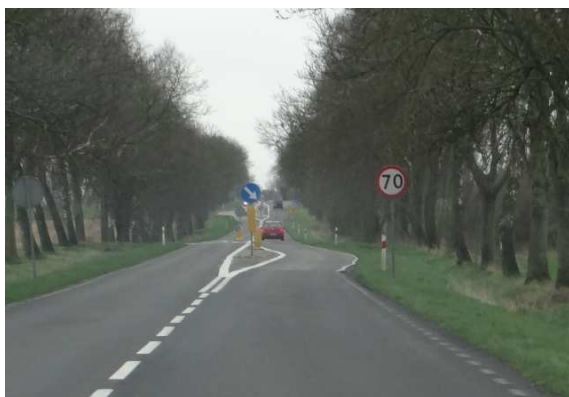
Ryc. 9.1. Widok odcinka badawczego Brodniki 1, kolejnej szykany i widocznej wyspy dzielącej na pobliskim skrzyżowaniu
