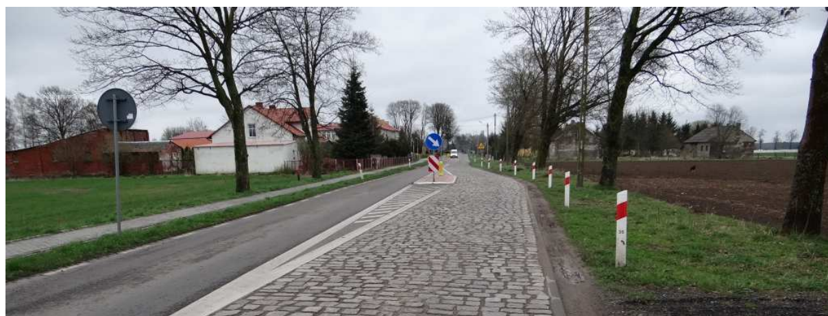
Ryc. 6.22. Przykładowe istniejące rozwiązanie z zastosowaniem słupków kierujących na DW105
