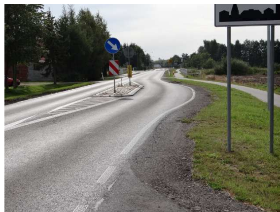
Ryc. 6.20. Odcinek Gleźnówko 2 i brak widoku sylwety wsi i widocznych zabudowań po stronie pasa wjazdowego ( \Delta v_{85} = 5,4 km/h)
