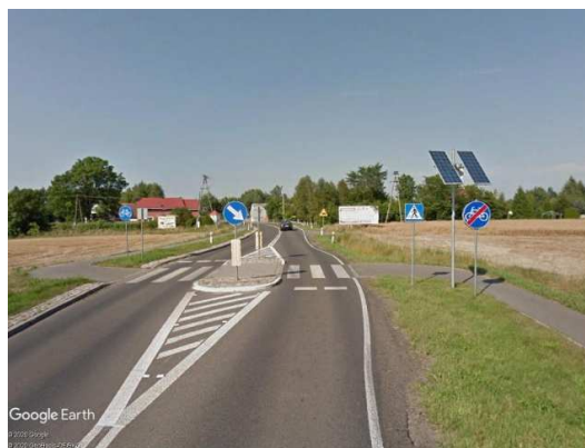
Ryc. 3.48. Widoczne budynki, chodniki, łuk poziomy i znak D-42 na odcinku Gleźnowko 1 [118]
