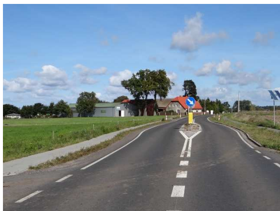
Ryc. 9.25. Widok szykany wybudowanej w osi drogi odcinków badawczych Gleźnowo 3 i Gleźnowo 3 (wyjazd)
