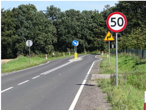
Ryc. 3.6. Szykana wybudowana w osi jezdni z odgięciem toru jazdy od kierunku prostego o 1 m
