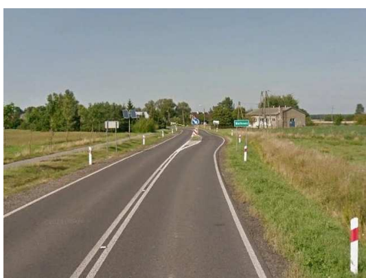
Ryc. 5.5. Przypadek widoku zabudowy wsi za znakiem E-17 stojącym 5 m przed szykaną i D-42 stojącym 30 m za szykaną
