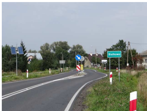
Ryc. 5.13. Widok bliskiej zabudowy w pobliżu szykany (Bielkowo 1), znak E-17 5 m przed szykaną i D-42 30 m za szykaną [141]
