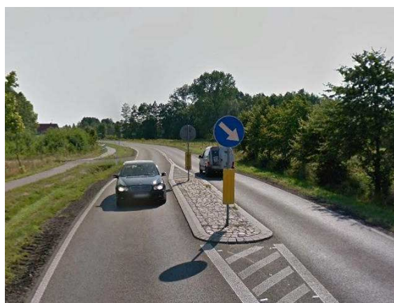
Ryc. 5.16. Brak widoku zabudowy wsi, w pobliżu szykany (Bielkowo 2), znak E-17 150 m za szykaną i D-42 300 m za szykaną [141]
