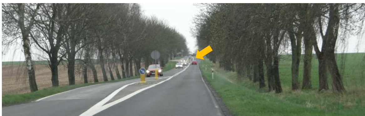
Ryc. 9.5. Widok wyspy podłużnej na skanalizowanym skrzyżowaniu przy zjeździe do wsi Lipnik i widok oznakowania poziomego P-4 długości ok. 250 m pomiędzy szykaną i wyspą dzielącą (odcinek Brodniki 1)
