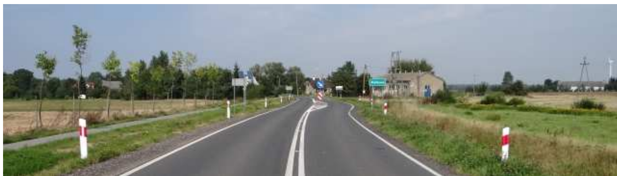
Ryc. 8.8. Strefa wjazdowa – Bielkowo 1 w otwartym terenie rolniczym – \Delta v_{sr}^{ppj} = 12,2 km/h, widoczne zabudowania w odległości od szykany ok. 50 m
