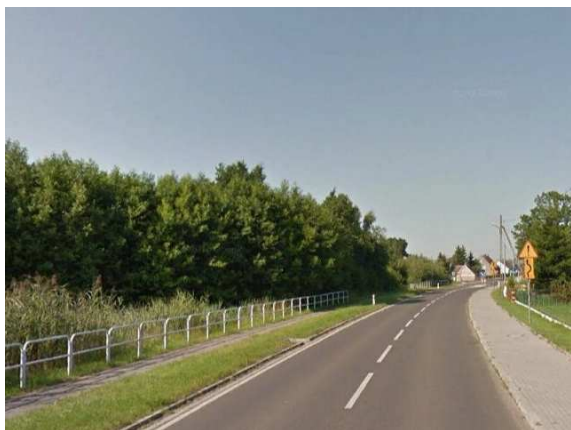
Ryc. 3.39. Dojazd do szykany na wjeździe do wsi Gleźnowo 2, znajdujący się częściowo w terenie leśnym
