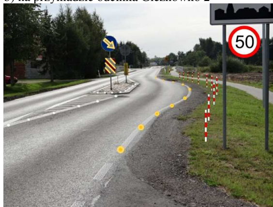
Ryc. 6.23. Wizualizacja poprawy warunków drogowych dzięki zastosowaniu: znaku B-33 w pobliżu szykany, odblaskowych słupków krawędziowych lub słupków drogowych, znaków pionowych zasilanych bateriami słonecznymi, dodatkowych krawężnikowych punktowych elementów odblaskowych o odbłyśniku wielokierunkowym PEO lub typu LED SolarCAP
