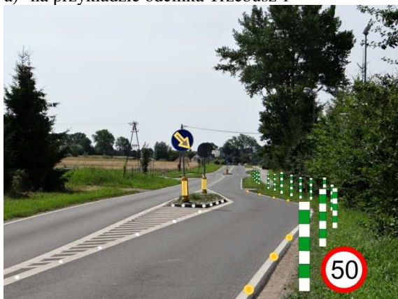
Ryc. 6.23. Wizualizacja poprawy warunków drogowych dzięki zastosowaniu: znaku B-33 w pobliżu szykany, odblaskowych słupków krawędziowych lub słupków drogowych, znaków pionowych zasilanych bateriami słonecznymi, dodatkowych krawężnikowych punktowych elementów odblaskowych o odbłyśniku wielokierunkowym PEO lub typu LED SolarCAP
