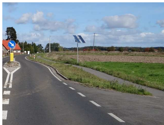
Ryc. 9.26. Widok odcinka badawczego Gleźnowo 3 (wyjazd) i otoczenia drogi po stronie pasa wyjazdowego
