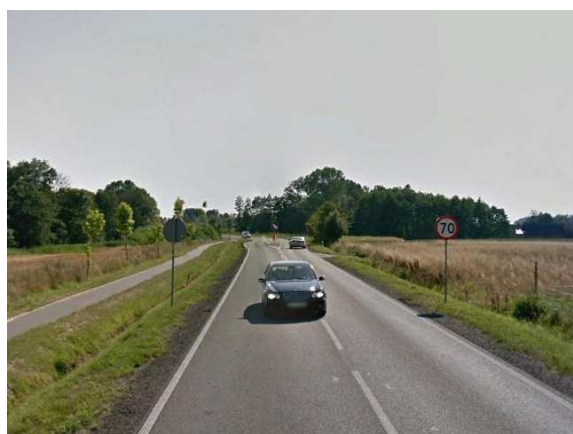
Ryc. 5.15. Dojazd do szykany i brak widoku sylwety wsi i zabudowy (Bielkowo 2) w pobliżu szykany wybudowanej w osi jezdni [141]
