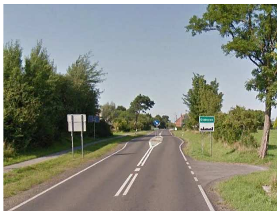
Ryc. 7.5. Dystrybuanty prędkości w ruchu swobodnym i widok odcinków badawczych, na których znaki E-17 i D-42 są zlokalizowane do 50 m przed szykaną
