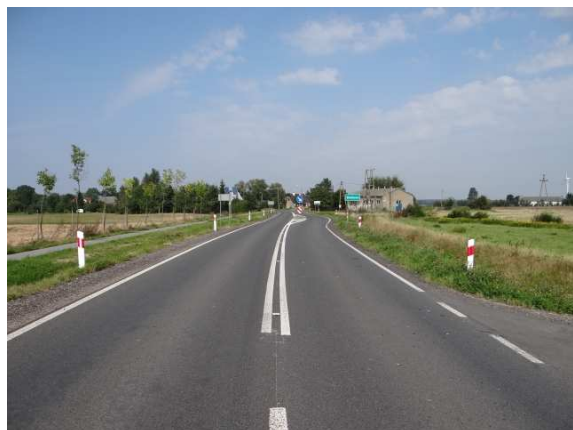
Ryc. 3.20. Dojazd do Bielkowa 1 w otwartym terenie rolniczym, przy bardzo dobrej widoczności sylwety wsi i bliskiej zabudowy
