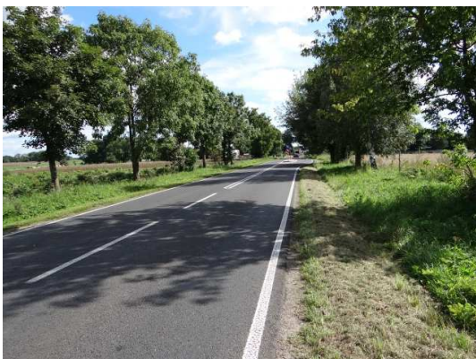
Ryc. 3.13. Dojazd do Krosina w terenie rolniczym wzdłuż szpaleru drzew i słabej widoczności sylwety wsi
