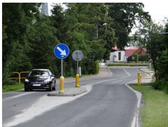
Ryc. 3.38. Przeszkoda boczna w postaci poręczy nad przepustem na wjeździe do wsi Trzebusz 2
