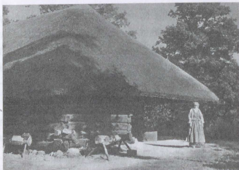
Ryc. 121. Noms z miejscowości Vainaičiai koło Plungian (lit. Plungė ), widoczny znaczny wysięg pocienia niepodpartego żadnym słupem (źródło: Lietuvių liaudies... [101])
