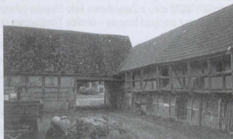
Ryc. 21. Wnętrze zagrody zamkniętej, widoczny przejazd bramny i budynek inwentarski z pięterkiem paszowym obsługiwanym z galerii – Dziadowo koło Nowogardu (fot. autora)
