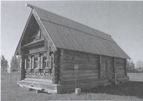
Ryc. 90. Dachy o większym nachyleniu połaci i daszki przycółkowe – przykłady rosyjskich domów eksponowanych w miejscowości Suzdal (zbiory autora))
