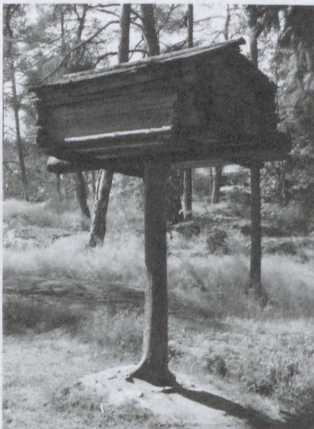
Ryc. 83. Drewniana budka spiżarni skonstruowana na pojedynczym, samorodnym słupie – pniu sosny ściętym na wysokości około 3,0–4,0 m, dostępna wyłącznie z drabiny (fot. autora)
