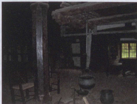
Ryc. 8. Organizacja urządzeń ogniowych w domach halowych: a) palenisko rozłożone bezpośrednio na klepisku – przykład ze skansenu Sorgenfri w Kopenhadze; b) palenisko podniesione na wyższe kuchnisko, obudowane ścianami bocznymi i przesklepione od góry – przykład ze skansenu Müß koło Schwerina (fot. autora)
