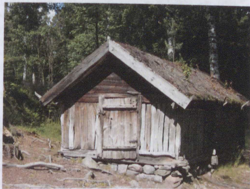
Ryc. 82. Zrębony domek lapoński z frontowym podcieniem, tu zabudowanym; zwraca uwagę niewielka wysokość obiektu (fot. autora)
