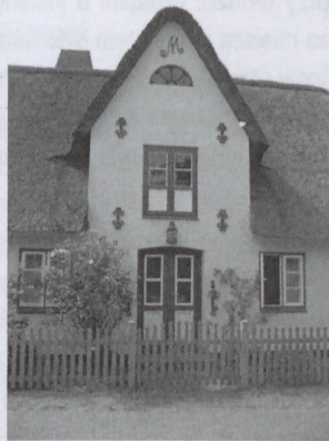
Ryc. 29. Facjatki o charakterystycznych formach akcentujące oś sieni i główne wejście do domów szlezwickich i północnofryzyjskich: a) przykład z miejscowości Sejerslev Północny (fot. autora); b) obiekt z miejscowości Nebel (zbiory autora)
