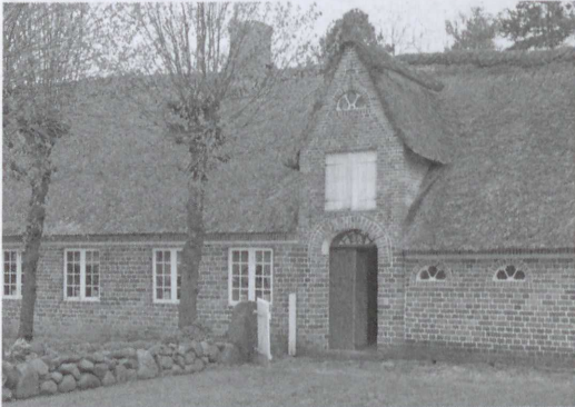
Ryc. 28. Front większej farmy, po lewej stronie sieni poprzecznej część mieszkalna, po prawej inwentarska – obiekt z miejscowości Sejerslev Południowy (fot. autora)
