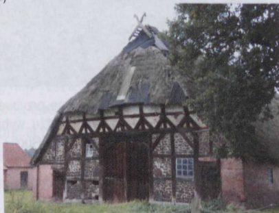
Ryc. 13. Forma dachów naczółkowych charakterystyczna dla omawianego obszaru, widoczne duże połacie naczółków nachylonych pod dużym kątem 14 , małe półszczyty i nadwieszony pięterko o dekoracyjnym układzie konstrukcji będące w Meklemburgii oznaką prestiżu i zamożności: a) i c) przykłady ze wsi Griben; b) i d) obiekty pochodzące z okolic Hagenow (fot. autora)
