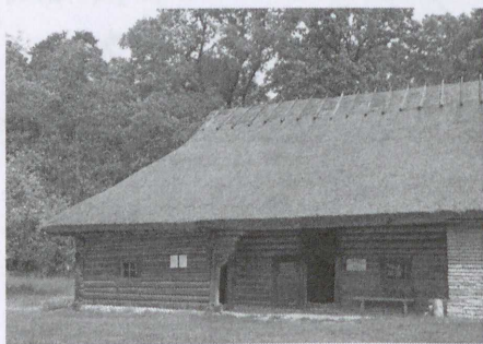
Ryc. 110. Podcień wzdłużny umożliwiający doświetlenie wnętrza rii właściwej, charakterystyczny dla obiektów tzw. grupy zachodniej; widoczna część stodołna wzniesiona z wapienia – dom z farmy Pulga we wsi Uuri, EVM (fot. autora)
