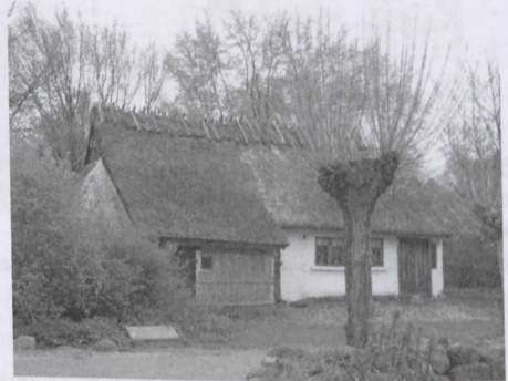
Ryc. 47. Poszerzanie konstrukcji o boczne „nawy” dla uzyskania w budynku dodatkowej powierzchni: a) schemat konstrukcji (rys. N.E. Jansen); b) chata robotnika rolnego z Englerup na wyspie Zelandia – obecnie w Sorgenfri (fot. autora)
