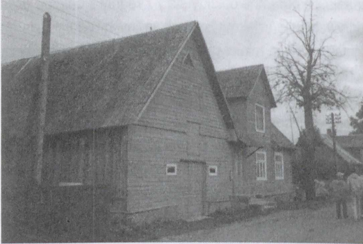
Ryc. 97. Wąskofrontowa stodoła o konstrukcji wieńcowej, powiązana z budynkiem mieszkalnym – przykład ze wsi rosyjskich starobrzędowców Calaste nad jeziorem Peipus w Estonii (fot. autora)
