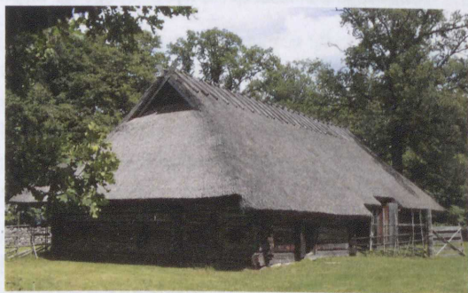
Ryc. 103. Charakterystyczna sylwetka wyróżniająca riję mieszkalną: długi budynek przykryty czterospadowym, nisko schodzącym dachem z dymnikami – rija z farmy Roosta na wyspie Saaremaa, obecnie w EVM 11 (fot. autora)
