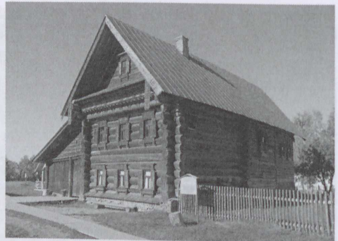
Ryc. 90. Dachy o większym nachyleniu połaci i daszki przycółkowe – przykłady rosyjskich domów eksponowanych w miejscowości Suzdal (zbiory autora))
