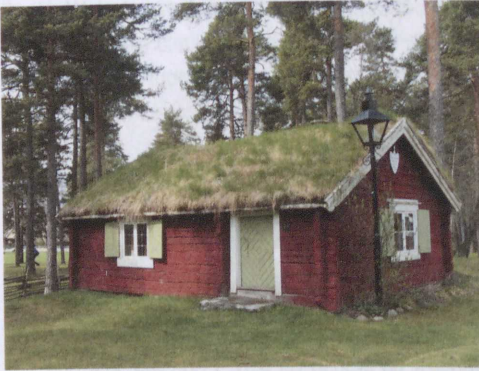
Ryc. 57. Prymitywna enkelstuga składająca się wyłącznie z jednej izby i przedsionka; zewnętrzne ściany niskie – góra przyziemia mieści się w wysokości ślegowego poddasza; właściwe dla tej konstrukcji dachu jest pokrycie darnią (fot. autora)
