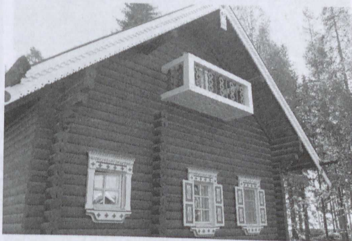
Ryc. 89. Końce belek ślegowych, stanowiących konstrukcję dachu, wyprowadzone daleko przed lico ściany szczytowej – ośrodek kultury karelskiej Bomba w miejscowości Numers w Finlandii (zbiory autora)
