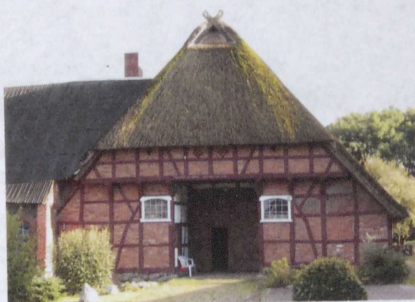
Ryc. 13. Forma dachów naczółkowych charakterystyczna dla omawianego obszaru, widoczne duże połacie naczółków nachylonych pod dużym kątem 14 , małe półszczyty i nadwieszony pięterko o dekoracyjnym układzie konstrukcji będące w Meklemburgii oznaką prestiżu i zamożności: a) i c) przykłady ze wsi Griben; b) i d) obiekty pochodzące z okolic Hagenow (fot. autora)
