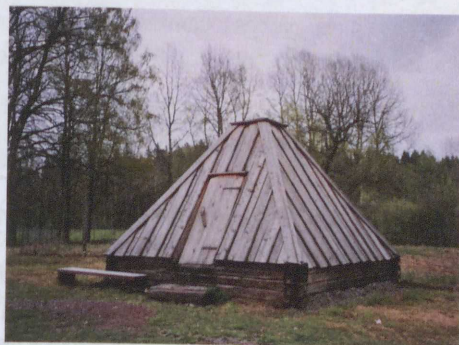
Ryc. 81. Czworokątna chata lapońska na podbudowie z kilku wieńców konstrukcji zrębowej – ekspozycja na terenie ośrodka Quarnap w Eksjö (fot. autora)
