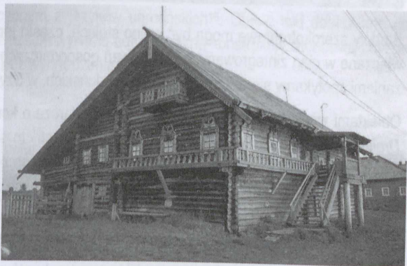
Ryc. 96. Dom Ponomariewa ze wsi Mańszino typu koszel stanowiący dwa długie wieńce konstrukcji zrębowej, ustawione równoległe i przykryte wspólnym dachem – ekspozycja na wyspie Kizi (źródło: khizi.karelia.ru)
