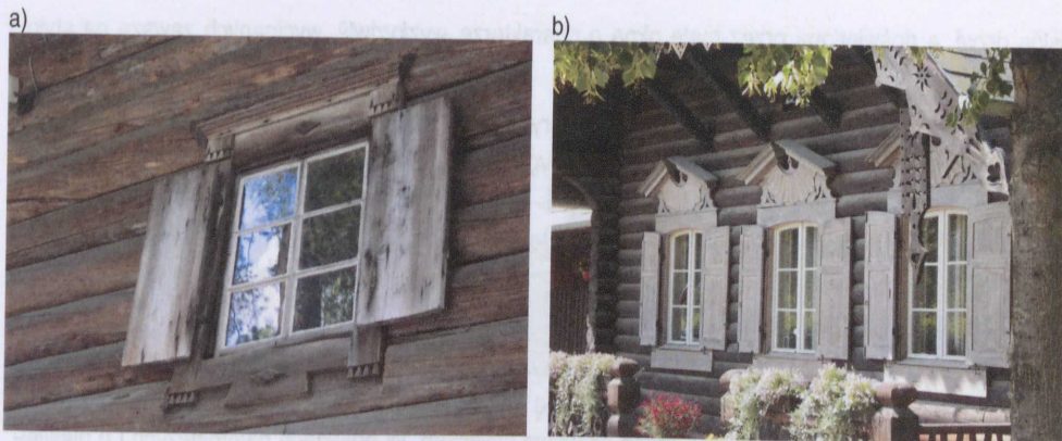
Ryc. 92. Charakterystyczne dla kompleksu rozbudowane obramienia okienne: a) przykład z Seurasaari; b) osie-dle Aleksandrovka w Poczdamie (fot. autora)
