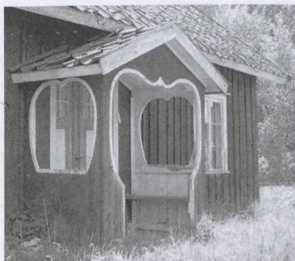
Ryc. 64. Kalenica daszku ganku mieszcząca się zazwyczaj pod okapem dachu budynku mieszkalnego (zbiory autora)
