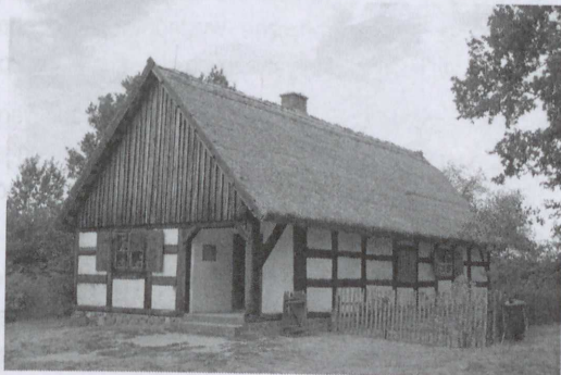
Ryc. 153. Przykład podcieniowego domu o konstrukcji ryglowej z Głubczyna, obecnie eksponowany w Osieku nad Notecią (zbiory autora)
