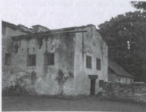
Ryc. 71. Dachy o niewielkim spadku kryte kamiennymi płytami, charakterystyczne dla starszych obiektów – przykład z XVII wieku z miejscowości Hamra (fot. autora)
