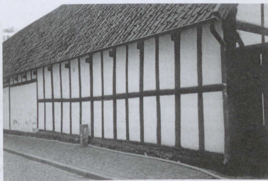
Ryc. 40. Charakterystyczny widok ściany o konstrukcji z ram typu „H”: naprzemienny rytm konstrukcji, pod okapem czoła belek stropowych – przykład pochodzi z Lund w południowej Szwecji (fot. autora)
