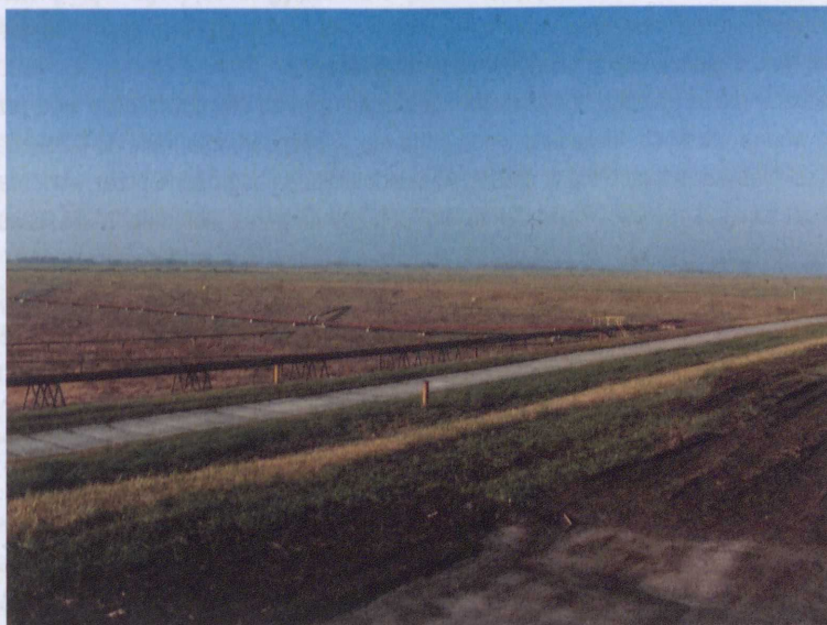
Fot. 1. Nadpoziomowe składowisko popiołożużli przy elektrowni Dolna Odra S.A. w Nowym Czarnowie (fot. G. Nowak)
