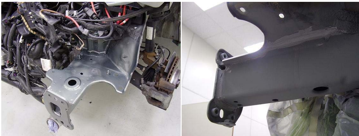
Rysunek 10.z. Poprawa estetyki wymienionej podłużnicy przez nałożenie masy wypełniającej i zabezpieczeń antykorozyjnych. a) widok od góry naprawianej podłużnicy. b) widok z dołu [4]
