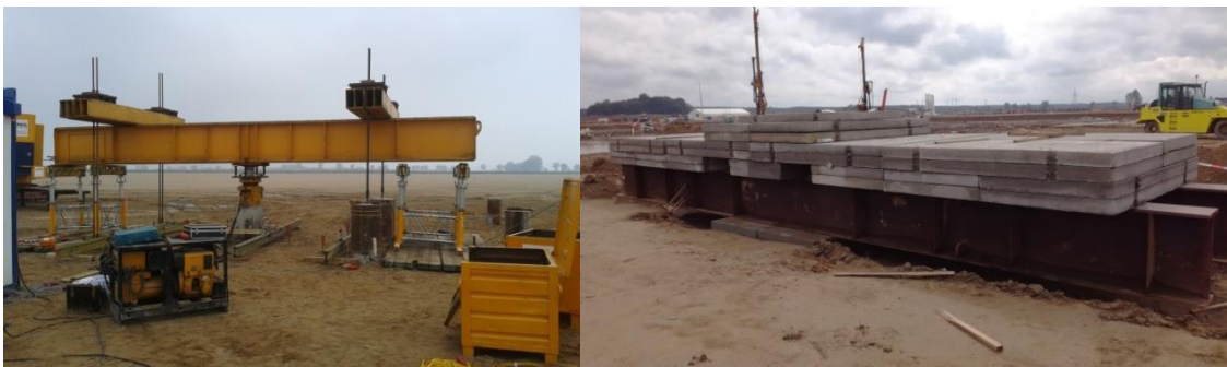
Zdj. 1.1 (od lewej) Test statyczny z użyciem pali kotwiących
