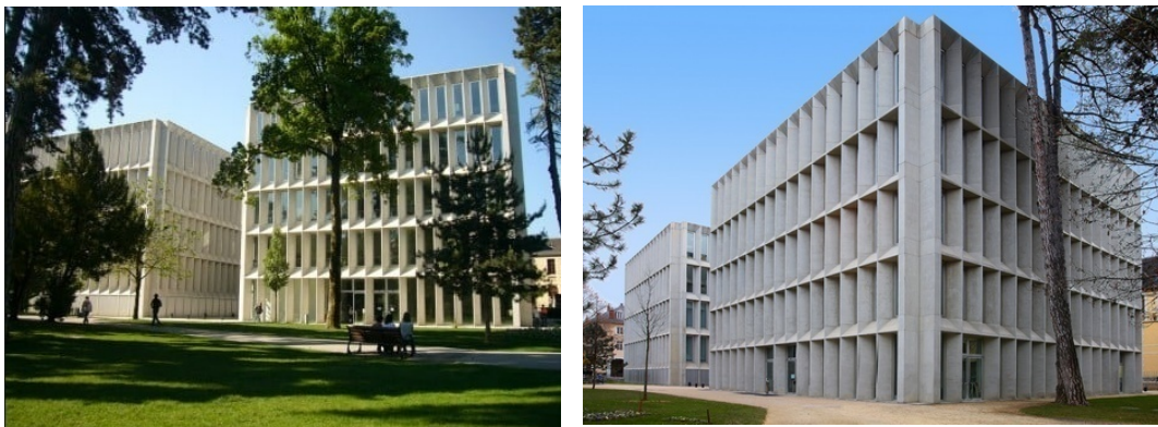
Rysunek 2.8. Miasteczko sztuki i muzyki we francuskim Chambéry, wykonane z fotokatalitycznego betonu [81]
