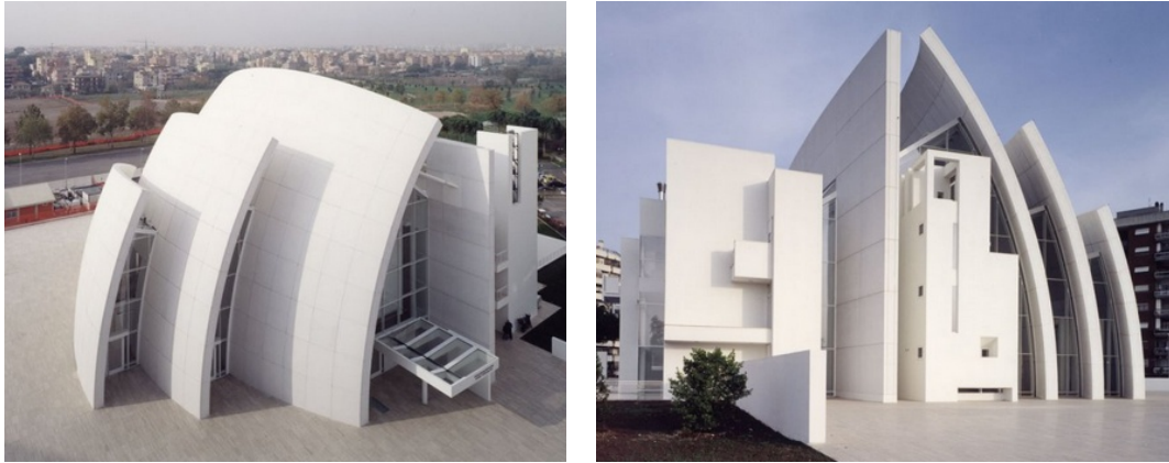
Rysunek 2.7. Kościół Dives in Misericordia w Rzymie, wykonany z betonu na bazie fotokatalitycznego cementu [80]
