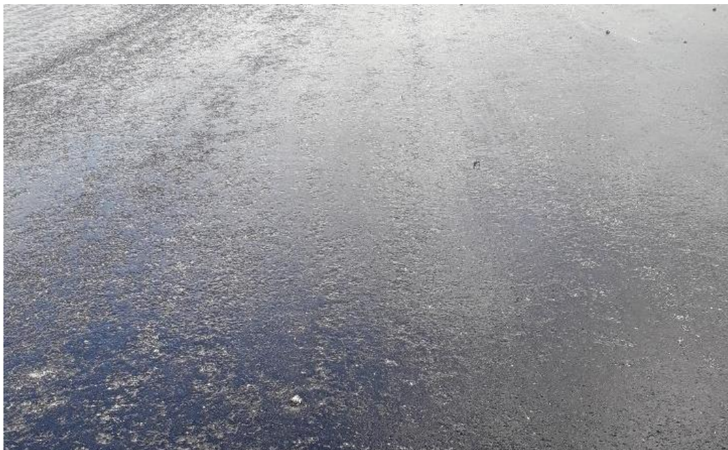
Rys. 2-10 Warstwa SMA-MA 8 PmB 65/105-60 po zagęszczeniu (widoczny wyciśnięty mastyks)
