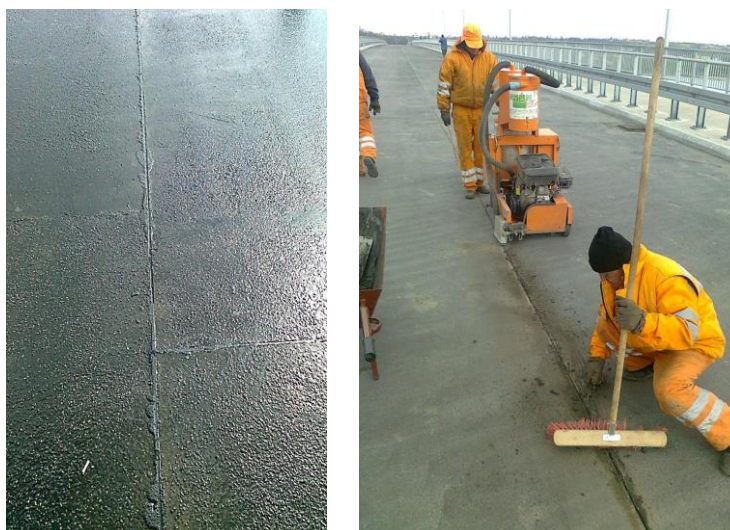
Rys. 2-18 Problem szwów technologicznych w warstwach ochronnych z asfaltu lanego [133]
