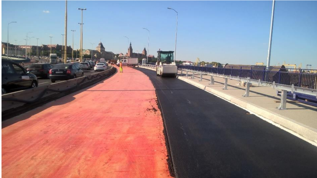
Rys. 2-9 Wbudowywanie warstwy ochronnej z mieszanki mastksowo-grysowej o zwiększonej zawartości mastyksu SMA-MA 8 PmB 65/105-60
