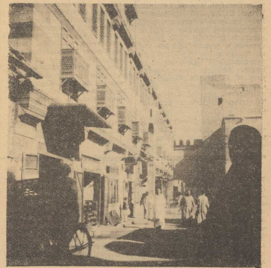
Na zdjęciu: dawny harem ze specjalnie zasłoniętymi oknami na I piętrze, gdzie mieszkali żony właściciela. Dekoracyjne zasłony przesłaniały widok z ulicy.
