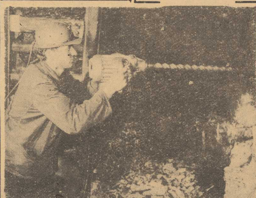
Na zdjęciu: wiercenie otworu strzałowego. CAF-fot. Seko
