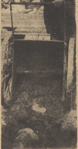
MIMO nie sprzyjającej aury, praca przy wykopach pod nowy wieżowiec przy ul. Wielkiej, przeznaczony dla PZM, idzie „pełną parą”. Na zdjęciu: wylewanie betonu pod tzw. ławę betonową na fundament przyszłego wieżowca. (Foto - St. Cieślak)
