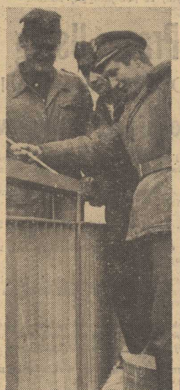
Ostatnie zabiegi kosmetyczne na moście. Nie mniej ważne od prac konstrukcyjnych. By malowanie było widać — krótka konsultacja żołnierzy — Z. LANGOWSKIEGO i W. POLCYN, a ich dowódcą — A. REKOWSKIM.
