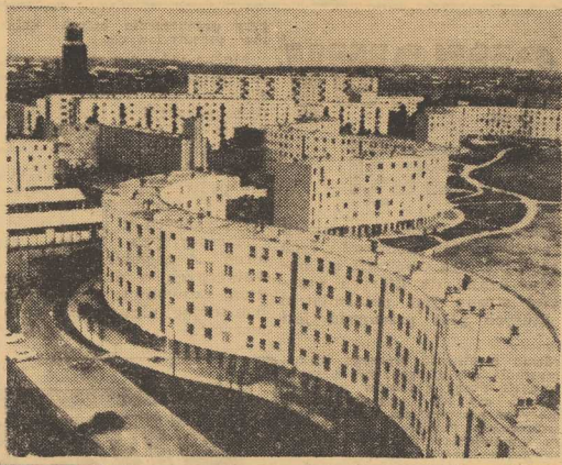
Francja. Nowe osiedle mieszkaniowe o ciekawej nowoczesnej architekturze w dzielnicy Bobigny w Paryzu.
