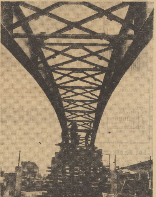
SZCZECIŃSCY SPÓŁDZIELCY, którzy wspólnym wysi-kiem budują piękną przystań wioślarską na Odrze (vis a vis Dworca Głównego) dokładają starań aby obiekt, przynajmniej w stanie surowym, oddać do użytku 22 bm. Wczoraj dokonana została bardzo ważna część całego przedsięwzięcia — prze-rzucono mianowicie ażurowe mostek (na zdjęciu), łączący wysepkę z prawym brzegiem Odr.
