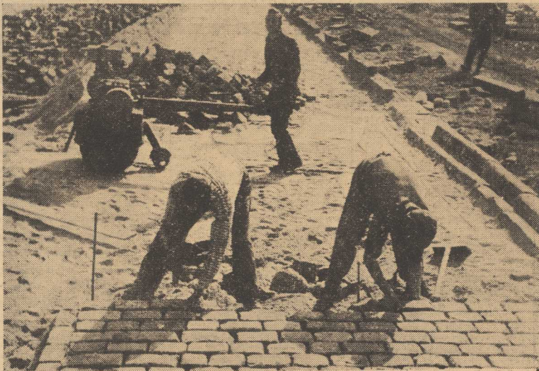
NARESZCIE uporządkowana zostanie ul. Gdańska na odcinku do Mostu Żmogusa. Będą więc dwie jezdnie po 10,5 m szerokości, każda trójstrumieniowa, środkiem przebieganie pas na tory tramwajowe. Na zdjęciu: pracując brukarze, dwaj Józefowie Arcisz i Kubik. Mechanicznym walcem kieruje Andrzej Zygieliński. (a)
