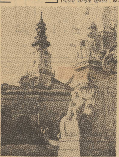
GŁÓWNA BRAMA starożytnego zamku, będącego ongiś siedzibą księcia Pribiny. Foto: V. PRIBNYL.
