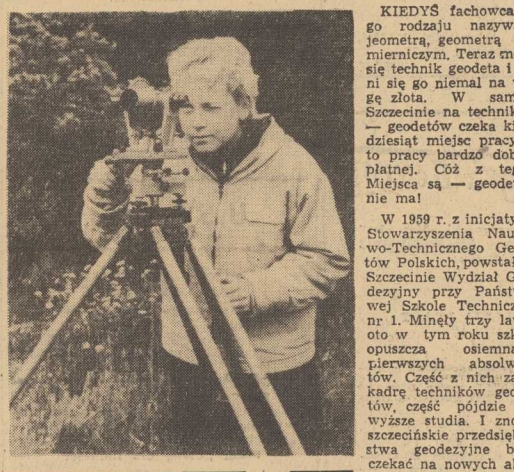
ELŻBIETA RAJNER z II roku zajęta jest wytyczeniem luk, przy pomocy teodolitu tachimetru, stużącego do pomiarów katów poziomych i pionowych oraz do opierania pomiaru odległości. Foto: Wanda CIEŚLAK
