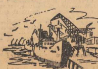
Pokonałmy wszystkie przeciwności, odrodziliśmy Szczecin. Dzieki dalekowzrocznej polityce Polskiej Zjednoczonej Partii Robotniczej i sprzy mierzonych z nią stronictw politycznych, dzieki władzy ludowej, pracą własnych rąk i umysłów dokonaliśmy nieodwracalnych przemian w dziele pełnego zespolenia Szczecina z całym krajem. Do piero w socjalistycznej Polsce Szczecin uzyskał szerokie perspektywy rozwoju i z zaniebanego w junkierskiej Rzeczypospolitej miasta przekształcił się w naj większy port Bałtyku, w dynamicznie rozwijającą się stolicę Pomorza Zachodniego.
