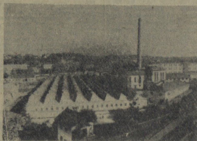
Na zdjęciu: Zakłady Elektrotechniczne „Iskra” w Kranj (Słowenia). FOT—CAF
