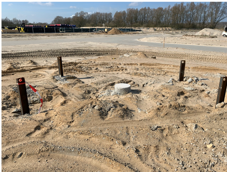
Rys. 37 Przygotowane stanowisko do wykonania konstrukcji do obciążenia pala [opracowanie Autora]
