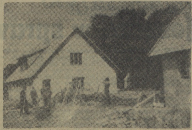
Gospodarstwo PGR — Suchorze zespół Barnów (woj. koszaliński) buduje dwa domy mieszkalne dla swych pracowników. Przy budowie pracuje 6-osobowa brigada murarska tego zespołu, która zobowiązała się oddać domy do użytku z początkiem października br. Fot. ORŁOWSKI
