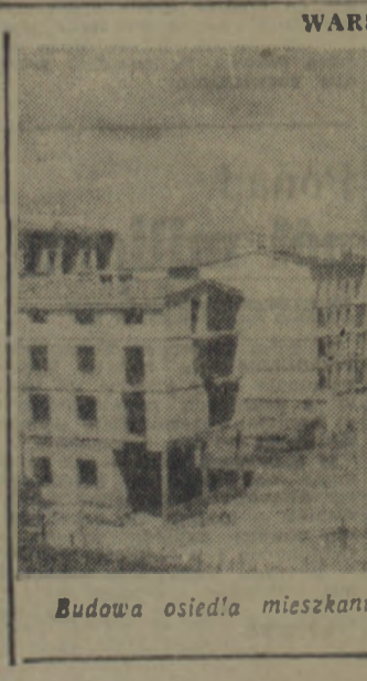
Budowa osiedla mieszkaniowego na Bielanych. CAF — fot. Szyperko
