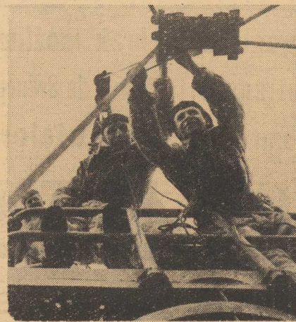
BRYGADA BORKOWEGO przygotowuje się do ostatniej operacji - wysokość 200 metrów.
