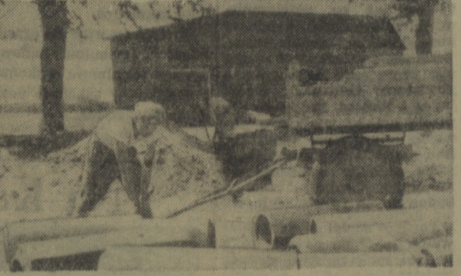
Budowa 3-kilometrowego odcinka drogi o nawierzchni brukowej, między wsiami Górzyno i Nieckowo w pow. Słupsk. Na zdjęciu: robotnicy przy wykonywaniu przepustu.
