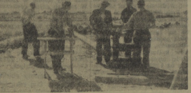
Trwają przygotowania do budowy mostu na rzece Łupawie między wsią Gardna Wielka i Słupsk w pow. Słupsk. Wybudowany most skróci objazd o około 15 km.
