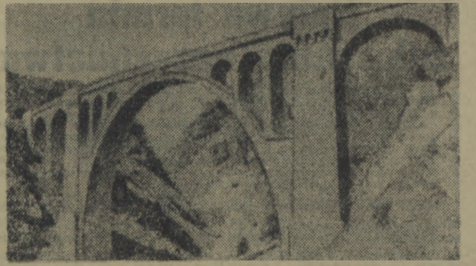
Człowiek francuski pokonał przyrodę. Wykuł drogę w skałach, przerzucił mosty nad przepaściami. Dzięki tym udogodnieniom turystyka rozwija się na szeroka skalę.
