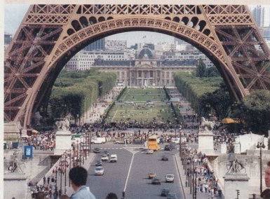
Wieża Eiffla – widok z placu Warszawskiego. W głębi widać Francuską Akademię Wojskową.
