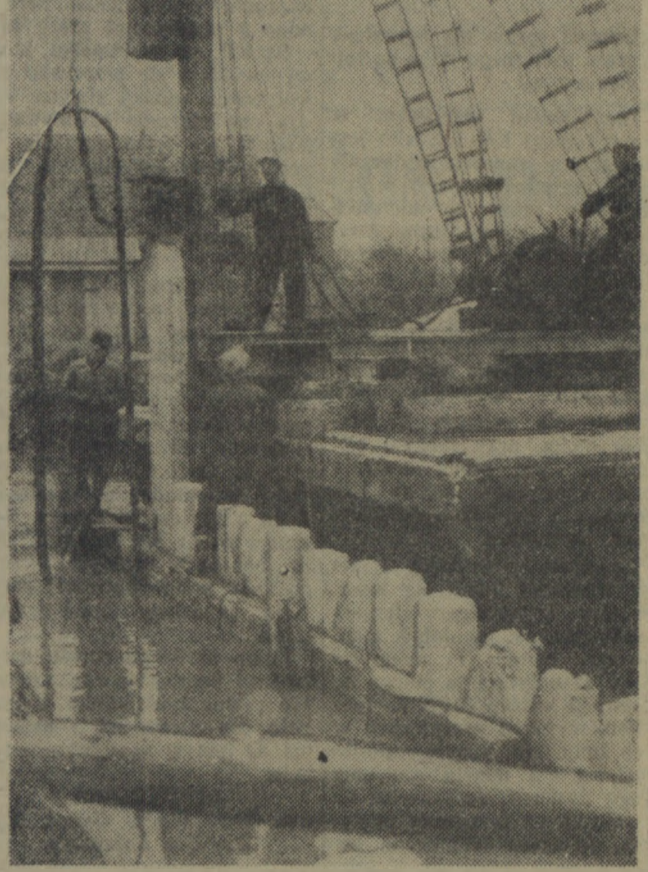
Brigada kolarzów Stanisława Egiera przy wbijaniu żelbetonowych pali.
