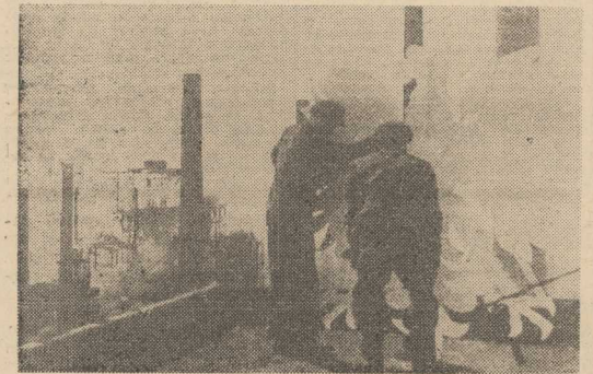
ŚLASKIE i zagłębiowskie zakłady wkrótce po wyzwoleniu przystąpiły do pracy.
