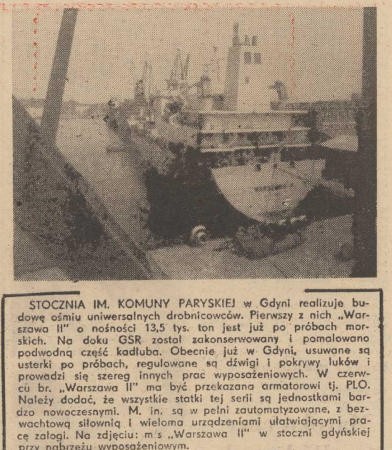
STOCZNIA IM. KOMUNY PARYSKIEJ w Gdyni realizuje budowę ośmiu uniwersalnych drobnowców. Pierwszy z nich „Warszawa II” o nośności 13,5 tys. ton jest już po próbach morskich. Na doku GSR został zakonserwowany i pomalowany podwodną częścią kadłuba. Obecnie już w Gdyni, usuwane są ustęki po próbach, regulowane są dźwigi i pokrywy luków i prowadzi się szereg innych prac wyposażeniowych. W czerwcu br. „Warszawa II” ma być przekazana armatorowi tj. PLO. Należy dodać, że wszystkie statki tej serii są jednostkami bardzo nowoczesnymi. M. in. są w pełni automatyzowane, z bezwachtową silownią i wieloma urządzeniami ułatwiającymi pracę załogi. Na zdjęciu: m/s „Warszawa II” w stoczni gdynskiej przy nabrzeżu wyposażeniowym.
