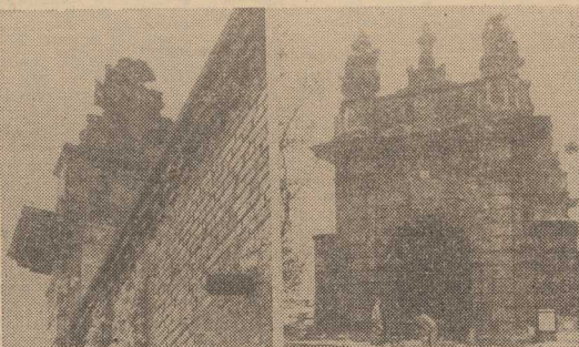
BRAMA Królewska tuż po usunięciu plotu. Obok — niestety rytna uparcie nie dostrzegana przez budowlanych...
