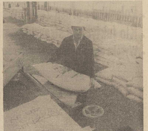
W ZAKŁADACH CHEMICZNYCH „Police II” trwa rozruch wytwórni moczniaka. W czasie przeprowadzanych prób otrzymano pierwsze tony nawozu, który trafił już do rolników woj. gorzowskiego i szczecińskiego. Prace rozruchowe potrwać kilka miesięcy.
